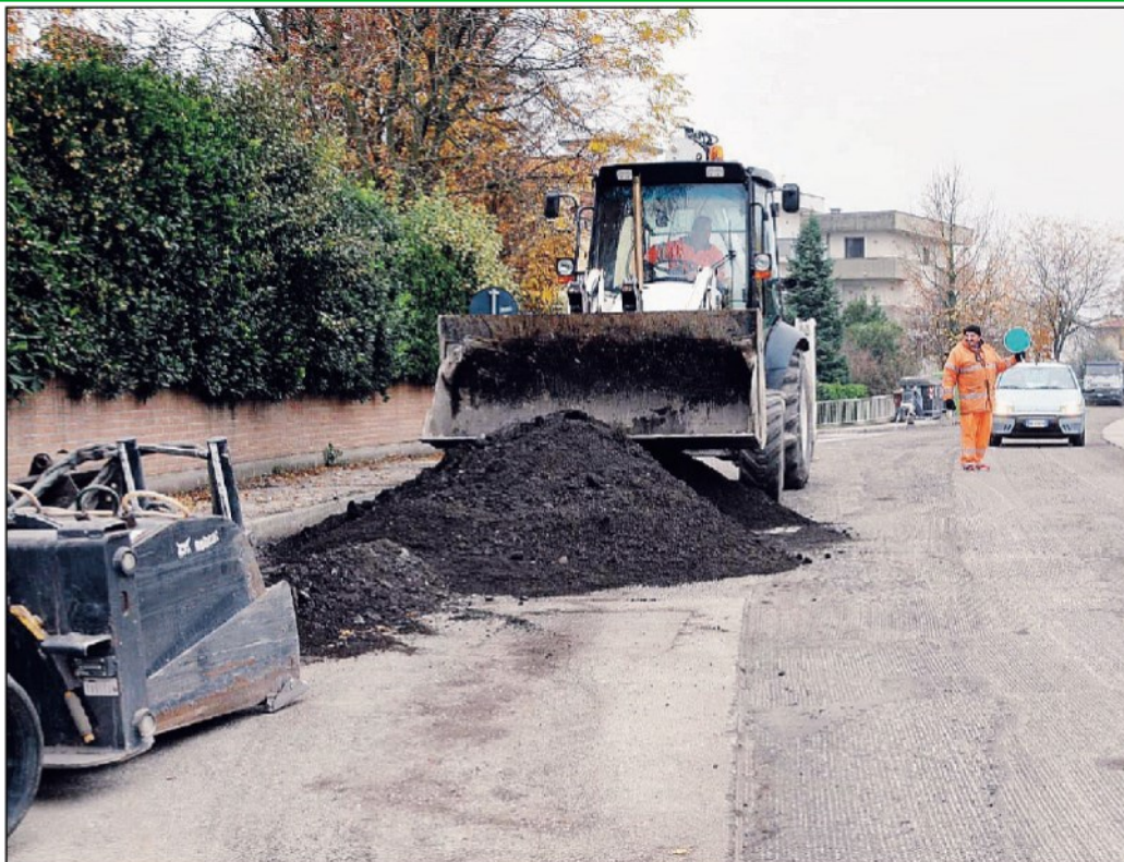
Affidati i lavori di asfaltatura nel capoluogo
