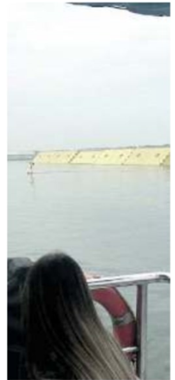
PROVE I test per verificare il funzionamento delle paratoie
