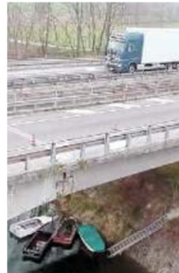
ALTA PADOVANA Situazione grave sul ponte di Curtarolo
