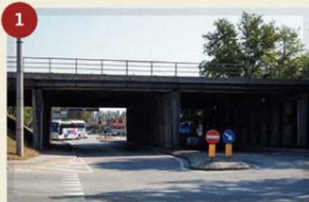
1 NUOVO PONTE IN VIA VIGONOVESE (Lavori in corso, 2,3 milioni di euro)
