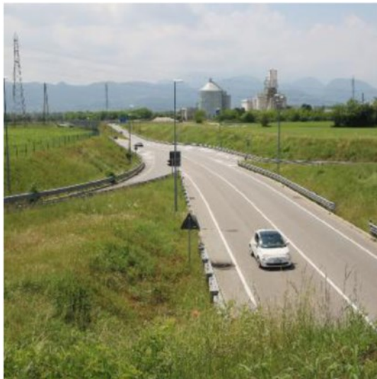
L'area dove verrebbe realizzato il casello autostradale
