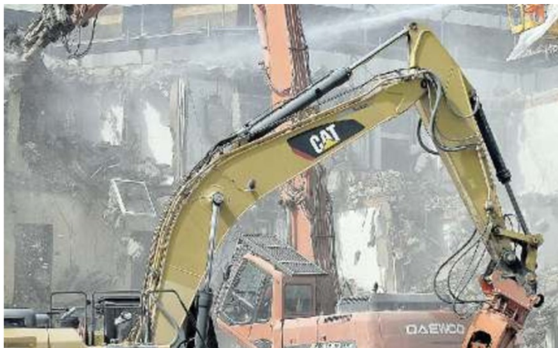
CANTIERE Nella foto di repertorio, i lavori di demolizione e ricostruzione di un edificio in Veneto
