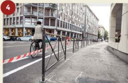
4 CORSO MILANO, NUOVA PIAZZETTA (finanziamento privato, lavori in corso)
