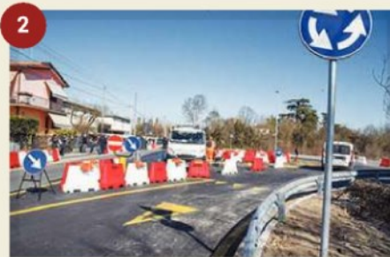
2 COMPLETAMENTO ARCO DI GIANO E CAVALCAVIA VIA MARONCELLI (6 milioni di euro, lavori in corso)
