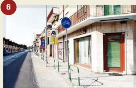
6 VIA BEZZECA, SISTEMAZIONE STRADA E ILLUMINAZIONE (200.000 euro, lavori in questo mese)
