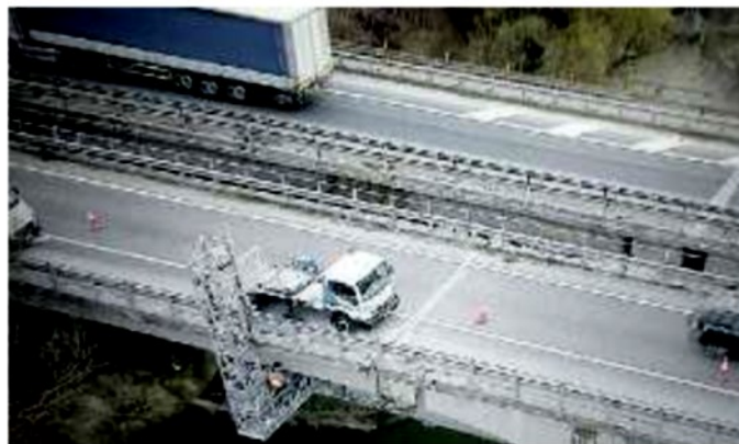
ALLARME Il ponte di Curtarolo durante i controlli
