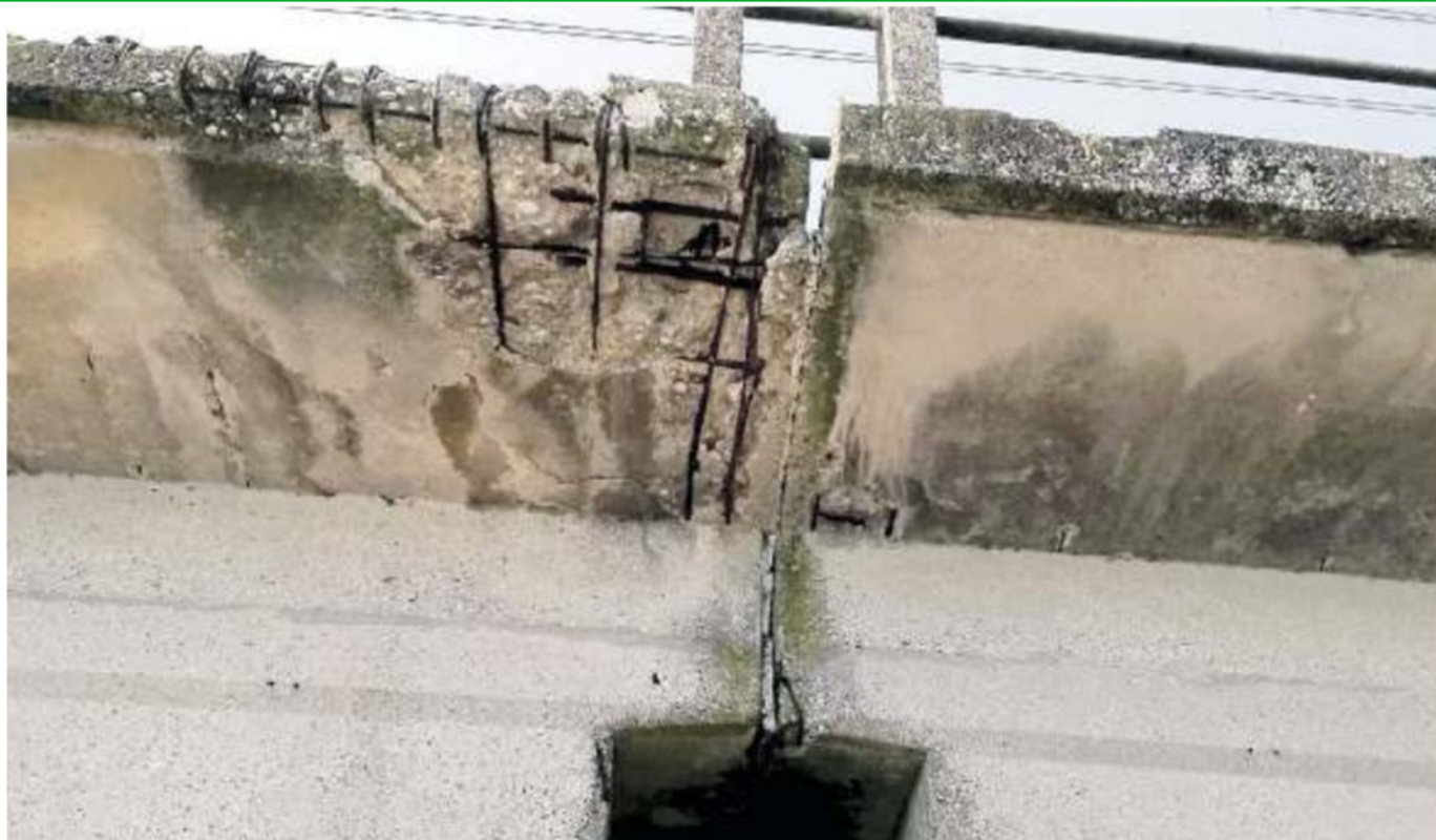
IL PONTE DELLA LIBERTÀ Particolare di una spalletta della struttura viabilistica che collega la terraferma con Venezia
