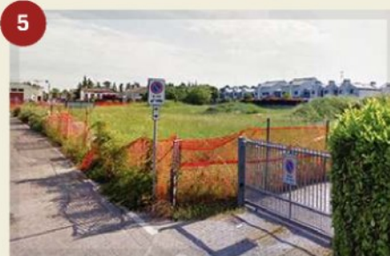
5 CHIESANUOVA, PARCHEGGIO VIA NACCARI (40.000, intervento quasi terminato)
