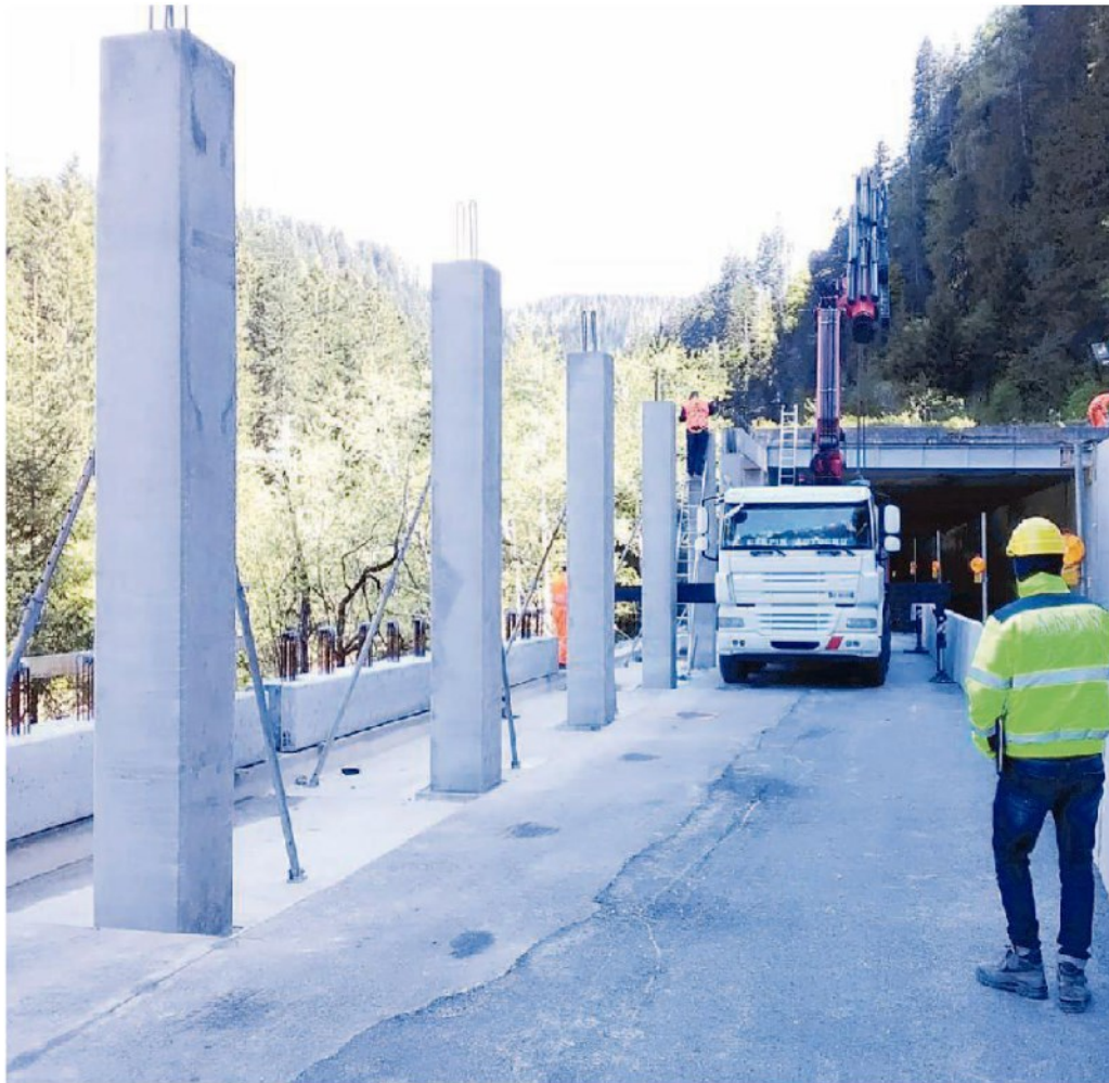
Gli attuali lavori in corso sulla statale Carnica a Santo Stefano per allungare il paramassi
