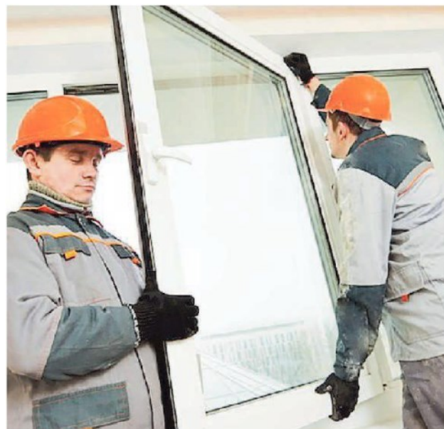
Serramentisti al lavoro in un cantiere edile
