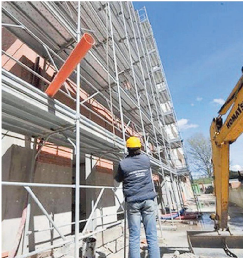
Allarme dell'Ance: 900 milioni di finanziamenti a rischio se non partono i cantieri
