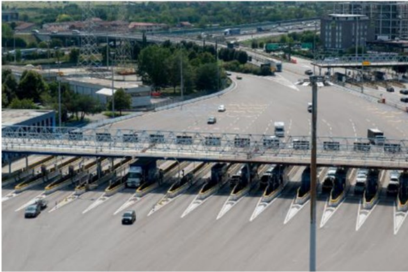
Una veduta panoramica del casello di Verona sud
