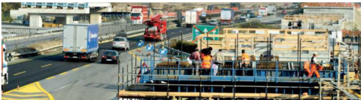
◀ Il cantiere Lavori in un cantiere dell'Alta Velocità sull'autostrada A4 Milano-Torino (foto d'archivio)
