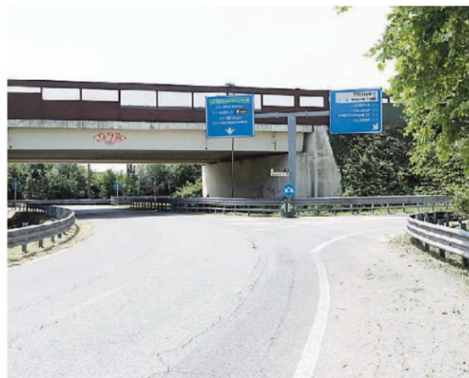
Rotonda ospedale: al braccio sud di viale Pasteur si sostituirà lo sbocco a nord del Terraglio Est
