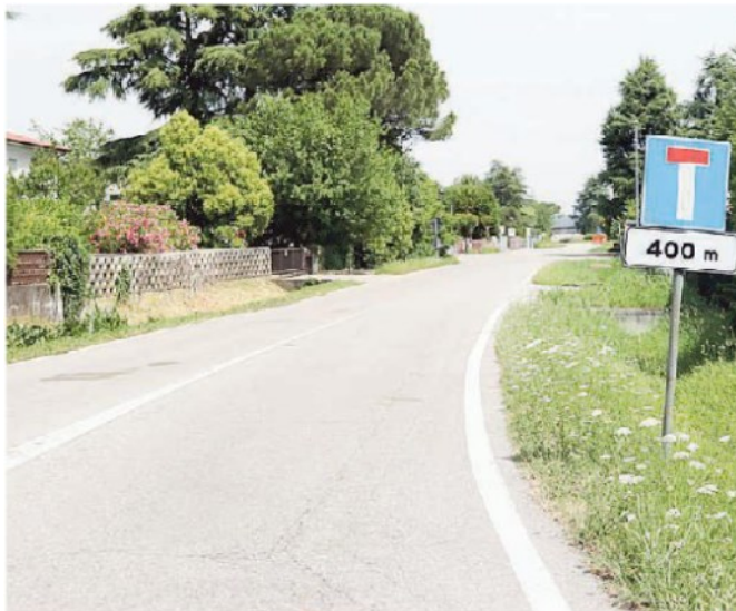
Il "binario morto": dalla fine di via delle industrie inizia la nuova sede stradale
