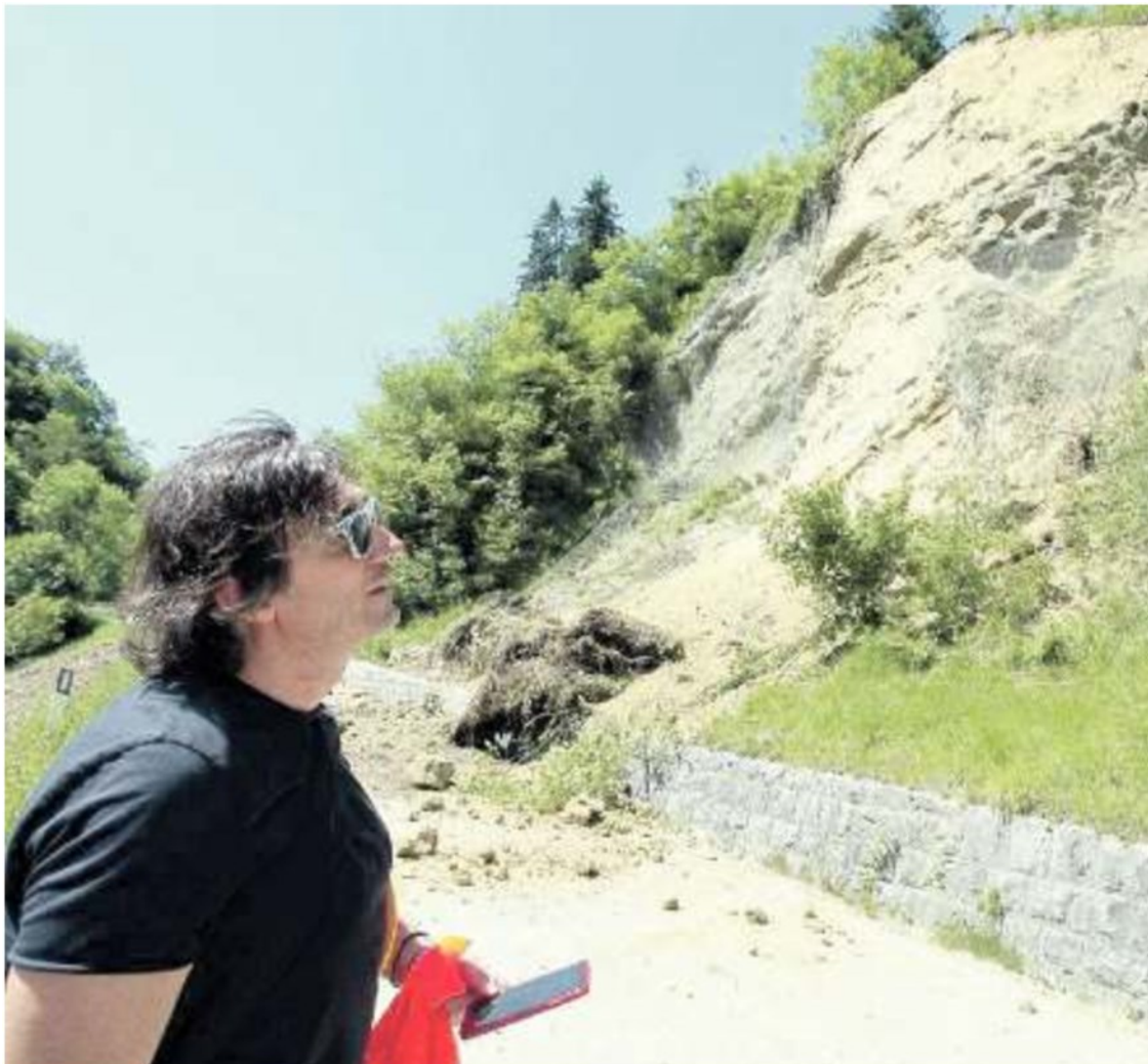
IL CANTIERE La parte della frana che dovrà essere profilata con una nuova esplosione
