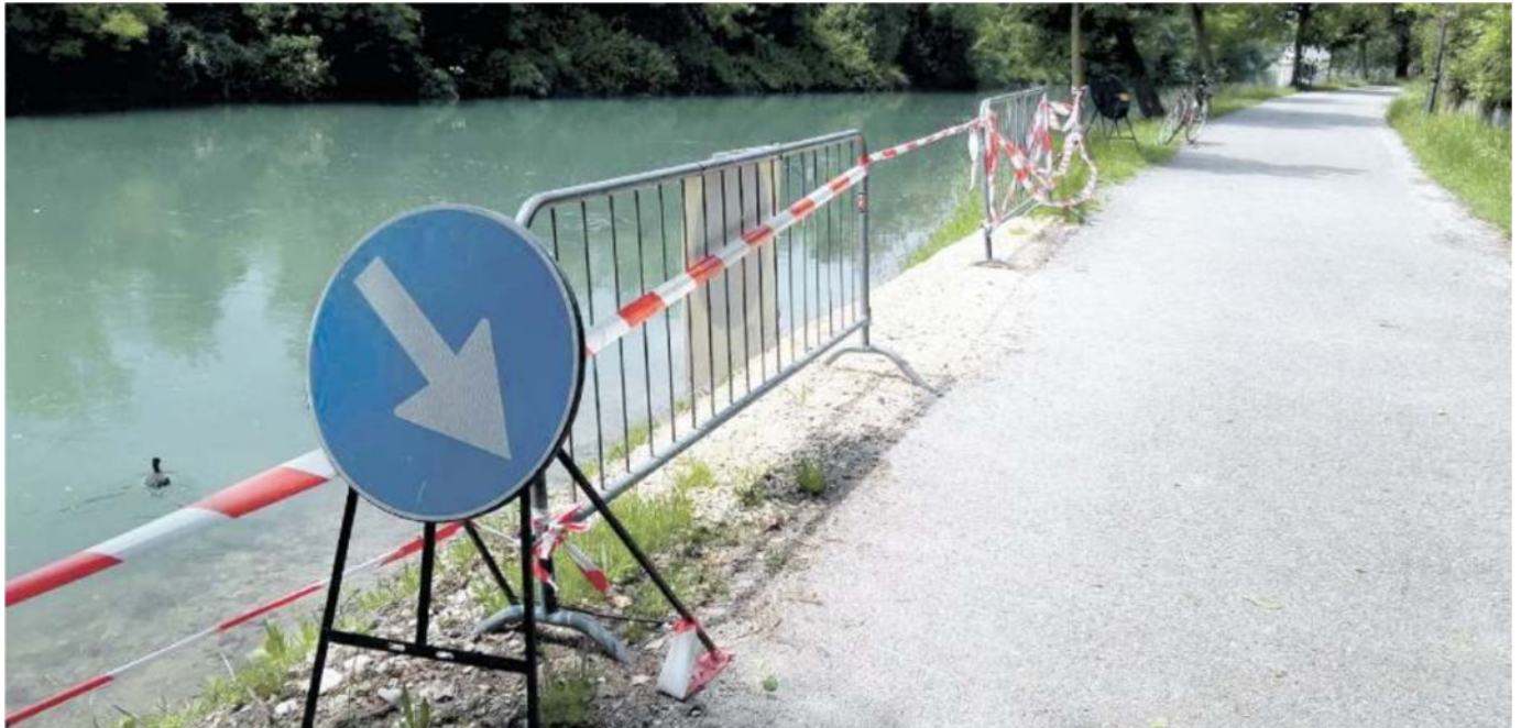
UNO DEI NUMEROSI tratti arginali che si affacciano sulla Greenway del Sile che sono sprofondata in acqua trascinando a volte anche degli alberi
