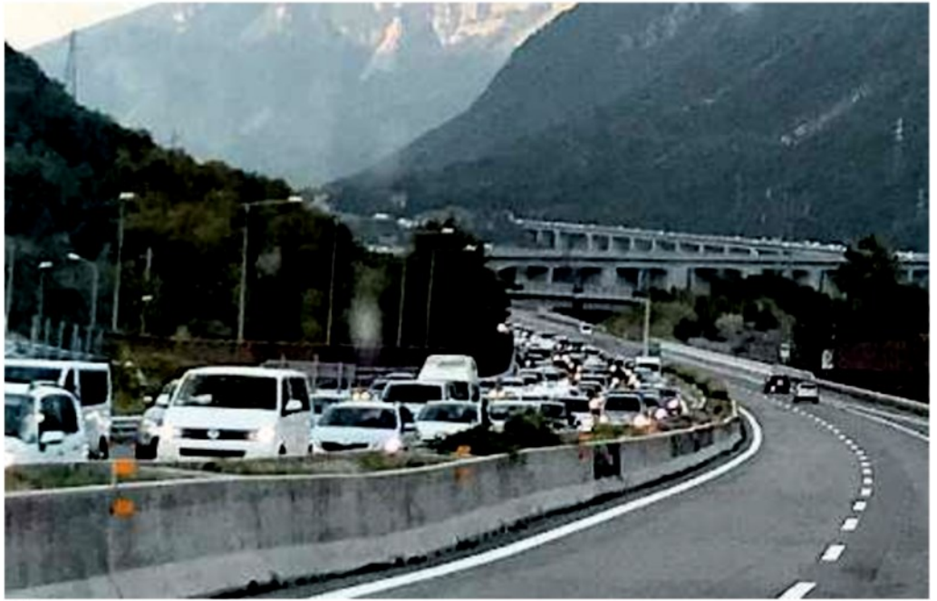
GIÀ IN FILA Domenica di passione per chi rientrava dalle montagne lungo l'autostrada A27: i lavori alla galleria di Vittorio Veneto, iniziati settimana fa, creano ingorghi e code chilometriche
