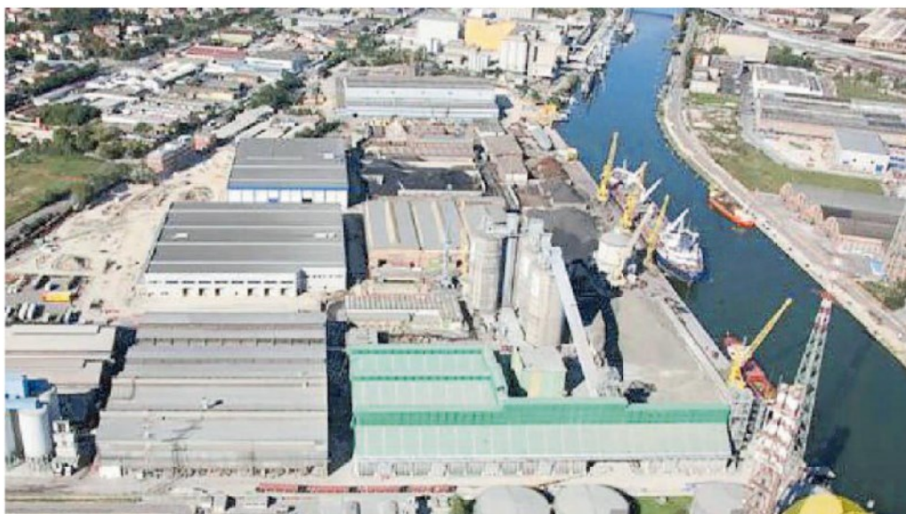
Una veduta del terminal del Centro Intermodale Adriatico
