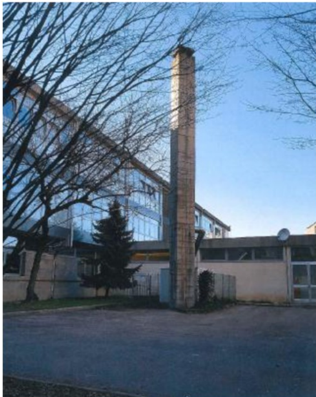
La canna fumaria della Calderari rischia di perdere pezzi
