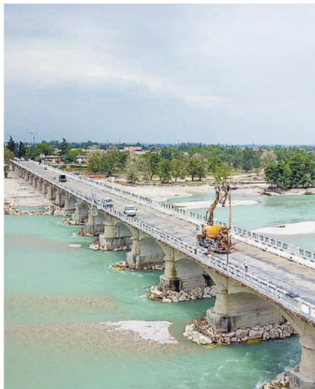
Gli ultimi lavori del cantiere che ha restaurato il ponte della Priula
