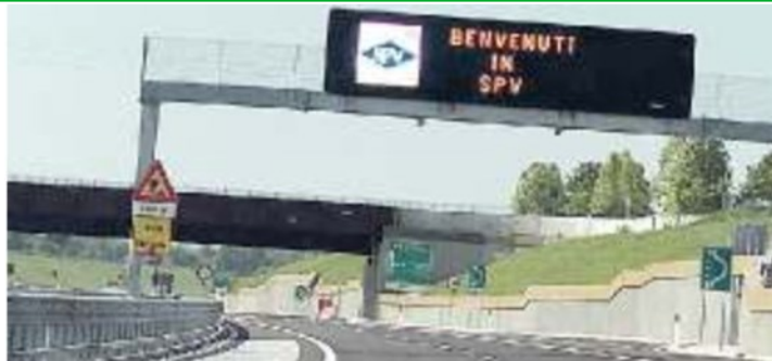
SUPERSTRADA Il primo tratto aperto al traffico della Pedemontana
