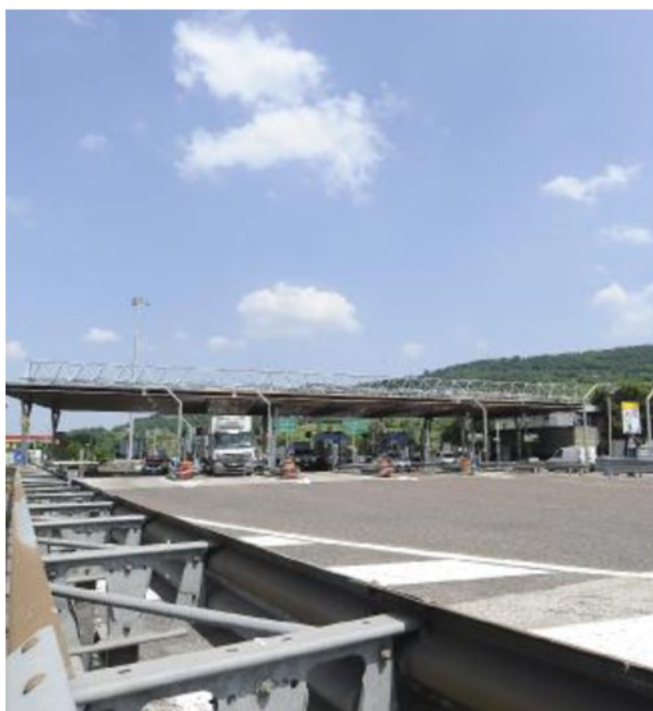
L'attuale casello dell'autostrada A4 di Montecchio Maggiore, ad Alte
