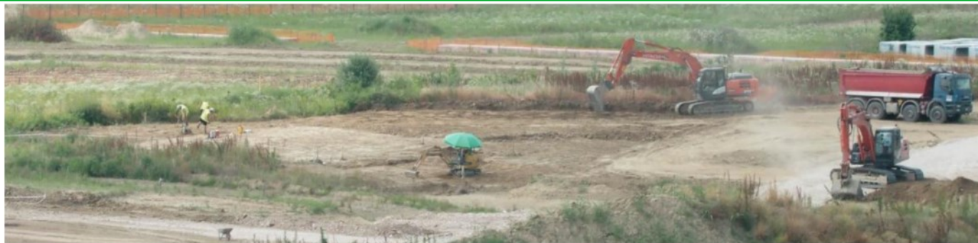
Un'immagine del cantiere della bretella dell'Albera all'altezza dello svincolo di viale del Sole: secondo il cronoprogramma sarebbero già dovuti iniziare i lavori per la creazione dell'impalcato del viadotto. SERVIZIO COLORFOTO
