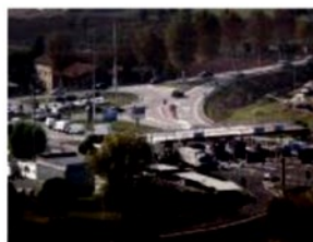
Il casello di Alte di Montecchio
