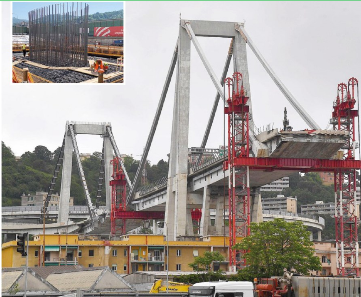
Pronto alla demolizione. Il Ponte pronto alla demolizione. Nel riquadro l'armatura del primo pilone della nuova struttura
