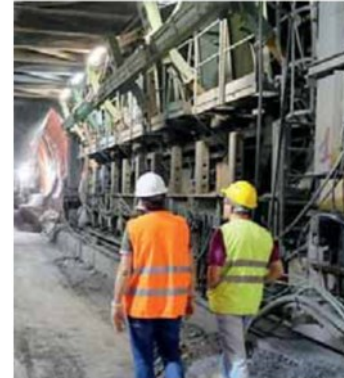
• Un convegno su appalti e cantieri
