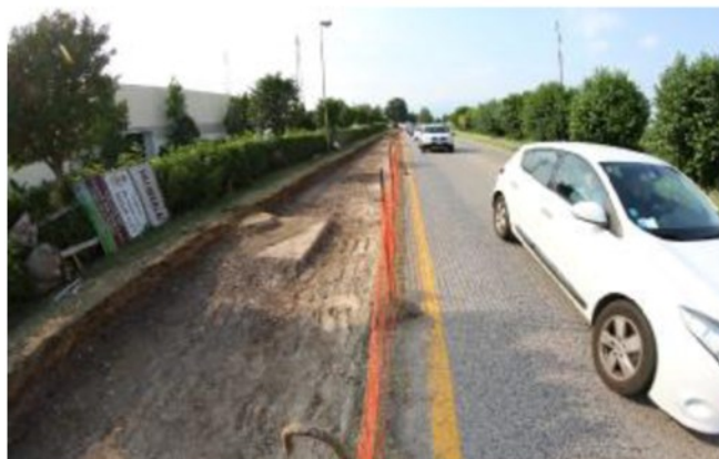
La zona dei lavori che verrà interessata dalle modifiche viarie. CISCATO
