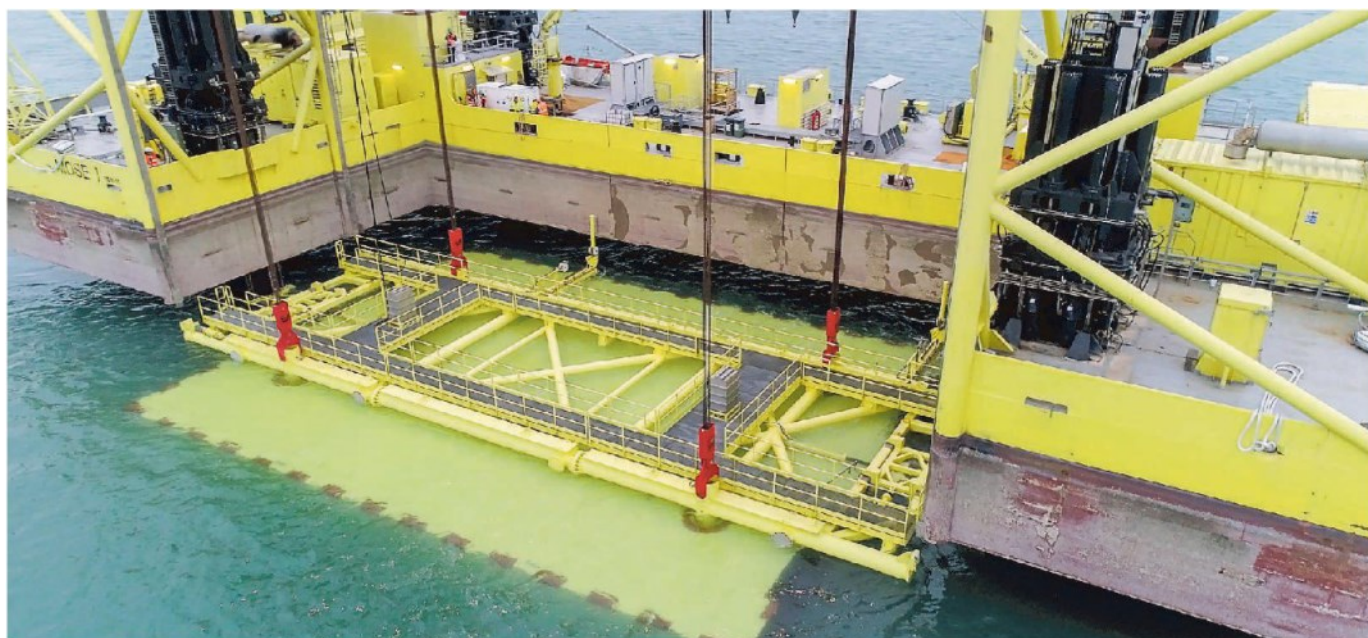
La posa dell'ultima paratoia del Mose al Lido, tre mesi fa. Calata dal jack-up, la nave attrezzata costata 52 milioni di euro
