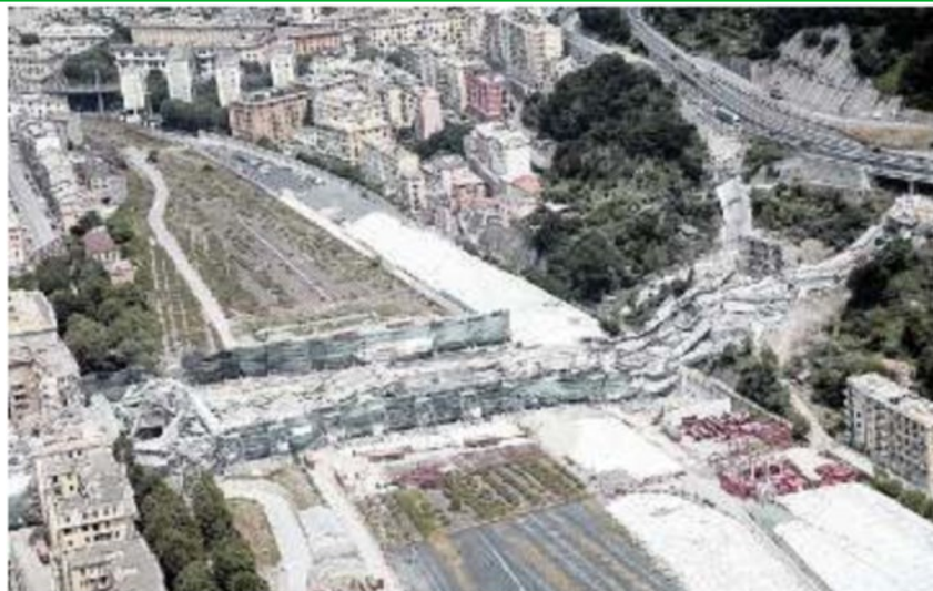
L'ESPLOSIONE L'area del ponte Morandi demolita l'altro ieri a Genova
