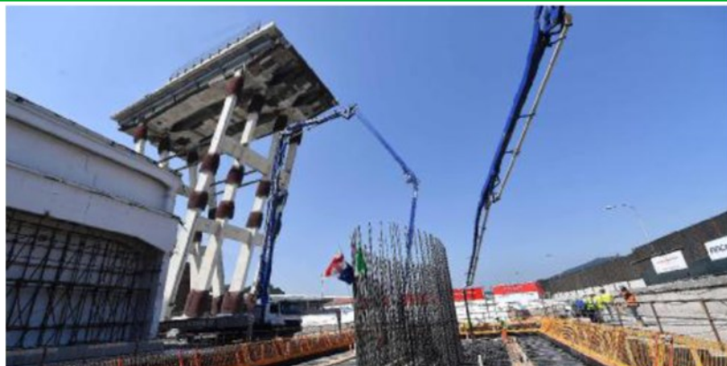
La prima gettata di cemento del pilone 9 del nuovo ponte di Genova: vicentini i controlli sugli acciai
