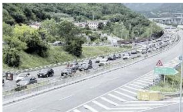
IL CANTIERE I lavori alla galleria del Monte Baldo creano rallentamenti e disagi al traffico in autostrada e in città
