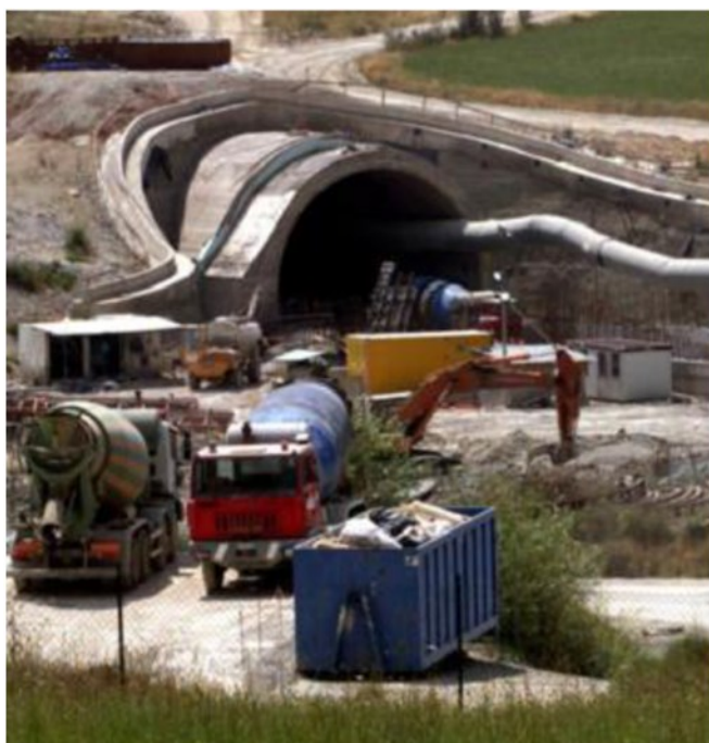
Mezzi all'opera in un cantiere per la realizzazione della Tav
