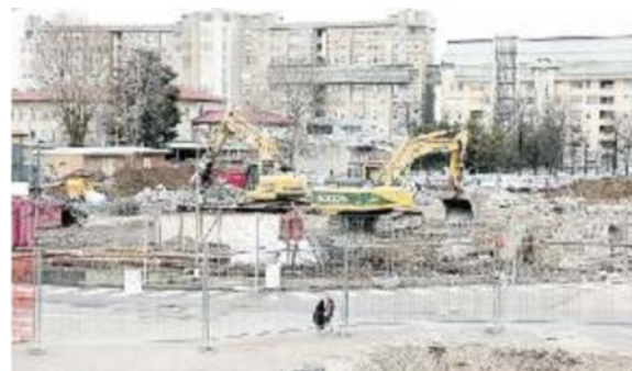
MAXI CANTIERE I lavori per la costruzione del nuovo ospedale in via Montereale a Pordenone, un "volano" per il comparto
