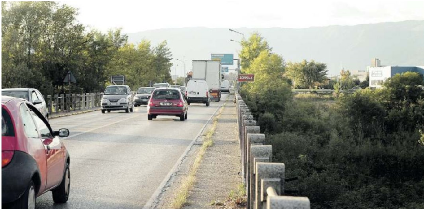
PONTE SUL MEDUNA Il viadotto all'ingresso est della città di Pordenone: ormai da anni si discute della necessità di un nuovo ponte a causa dell'"imbuto" al traffico
