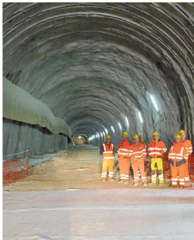
Il cantiere per la costruzione della galleria di Malo
