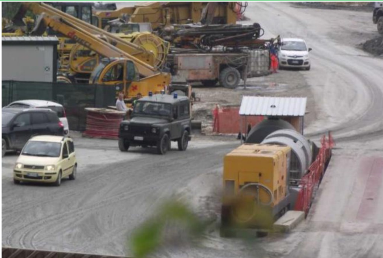
Il cantiere della Pedemontana è stato posto sotto sequestro per l'ipotesi di frode ai danni della Regione Veneto
