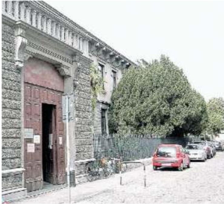
RESTAURO Lavori alla elementare Ardigò e alla media Mameli
