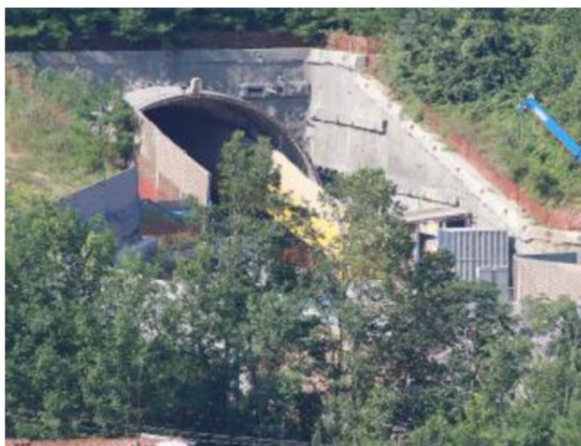
L'imbocco del tunnel della Pedemontana al centro dell'indagine
