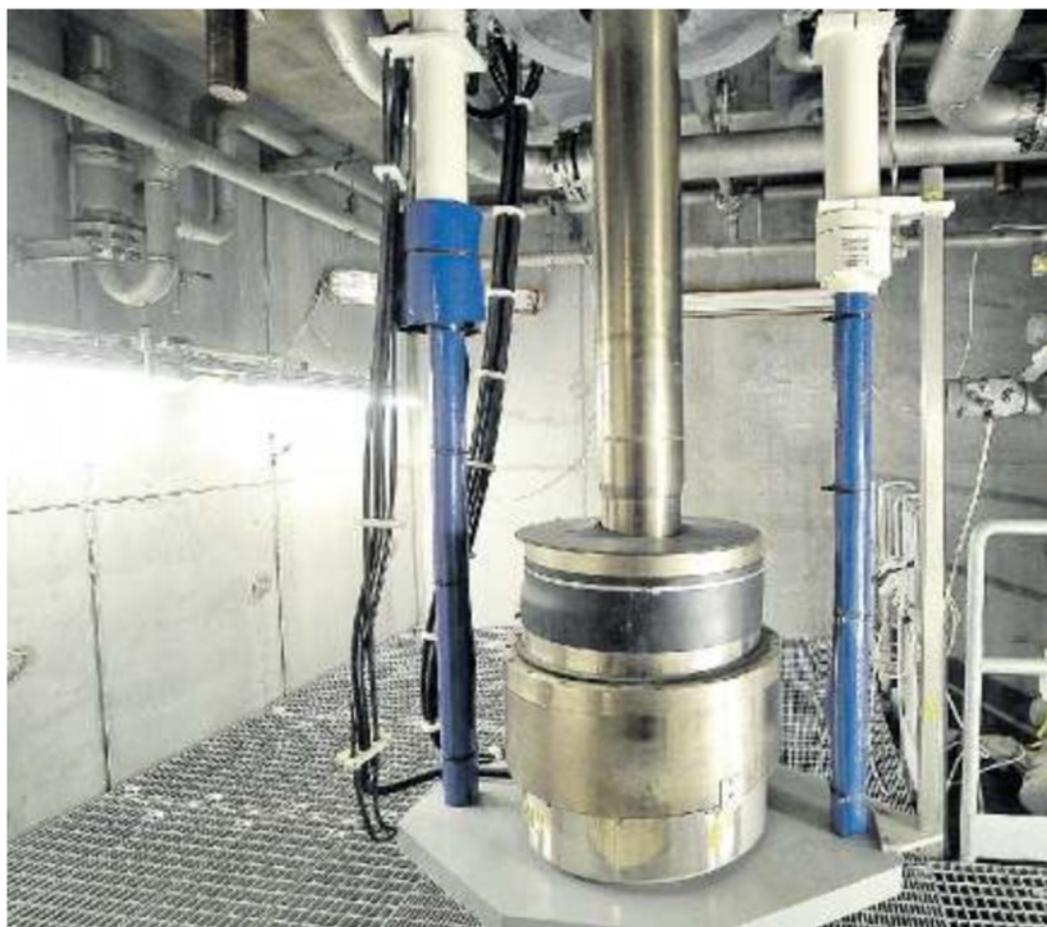
I MECCANISMI Gli "interni" delle dighe mobili che contengono i sistemi per azionare le paratoie
