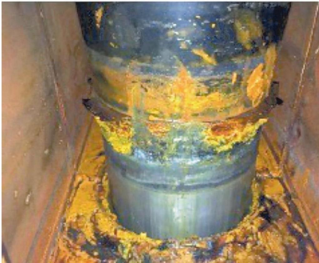
Melma e corrosione sulla cerniera del Mose sott'acqua
