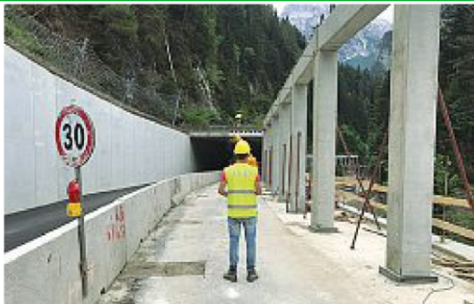
Tappe forzate Il cantiere sulla strada statale 52 «Carnica» in Comelico
