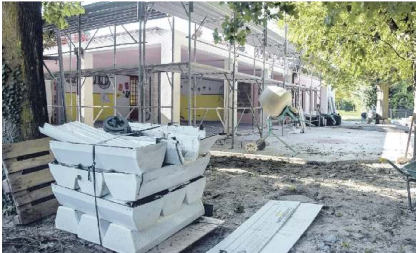
SCUOLA D'INFANZIA Il cantiere della Peter Pan di via Bernini, a Mira Porte, dove sorgerà un'aula "smart" (rendering in alto).
