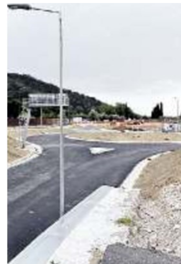
I LAVORI La rotatoria di Rindola al termine del traforo
