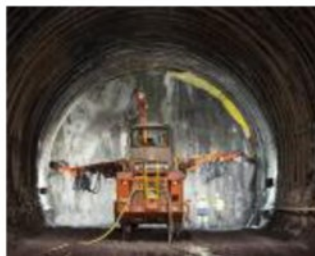
Il cantiere Tav della Torino-Lione
