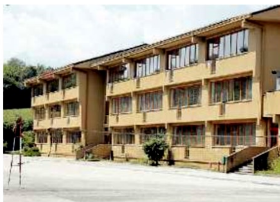
I CANTIERI Anche il Calvi in futuro sarà oggetto di lavori
