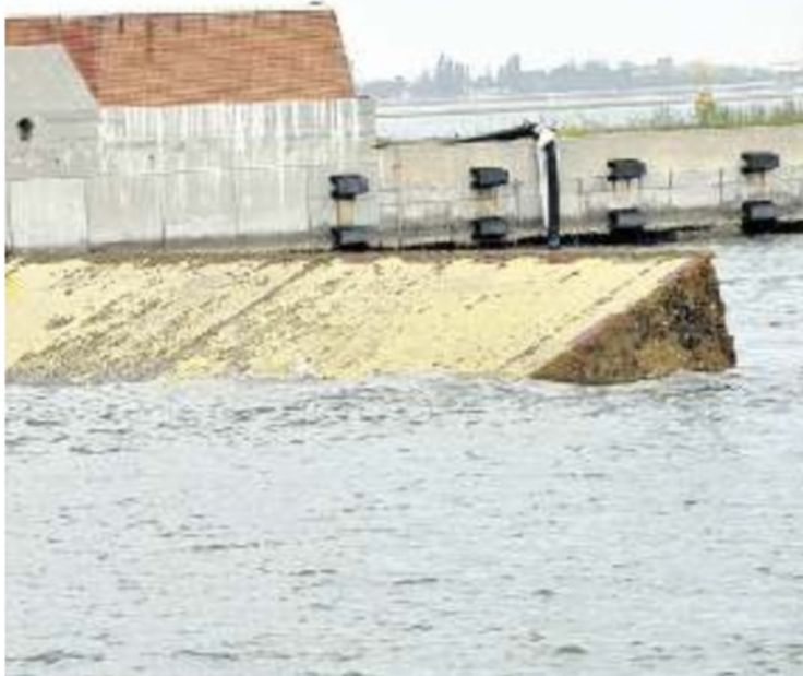
MOSE Una prova delle paratoie alla bocca di porto del Lido
