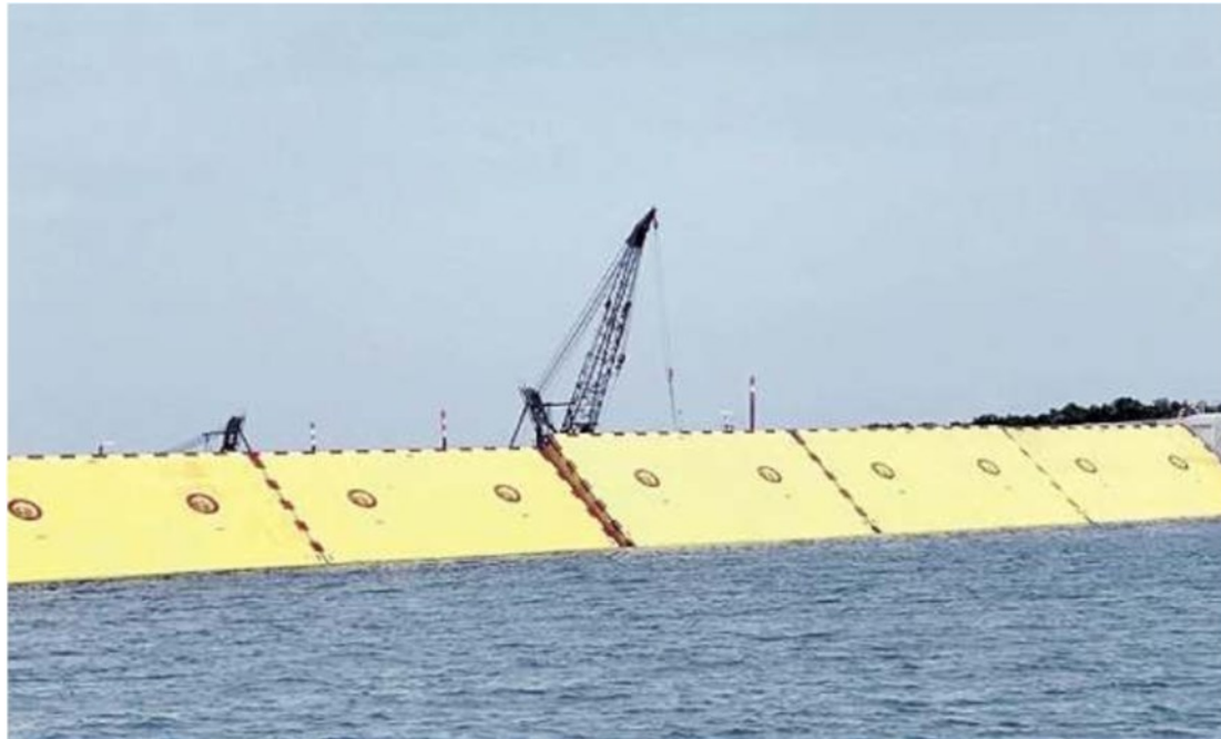
BOCCA DI PORTO DI CHIOGGIA Un momento della prima prova di sollevamento delle paratie del Mose
