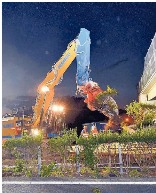
Lavori in corso per la terza corsia della A4
