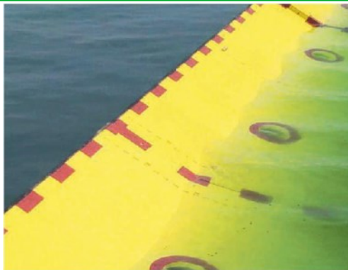
Le paratoie durante una prova di collaudo
