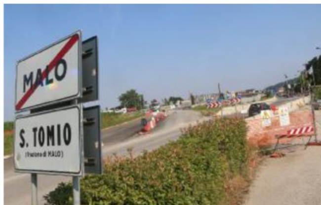
Il cantiere della Pedemontana a Malo sotto sequestro. STUDIO STELLA
