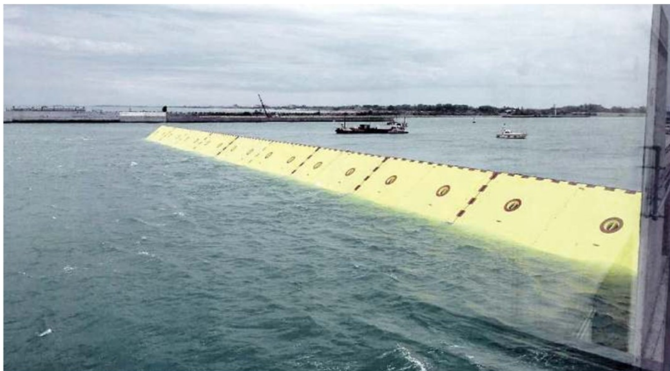
PROVA DI SOLLEVAMENTO Le paratoie mobili del Mose durante l'ultima prova di sollevamento. Ci sono ancora diversi problemi da risolvere
