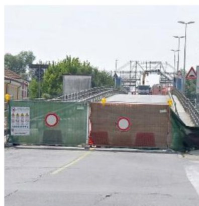
Sopra, Andrea Frigato e Luciano Siviero a pochi passi dal cantiere. A sinistra, alcune paratie sono state collocate sul ponte per fermare il traffico
