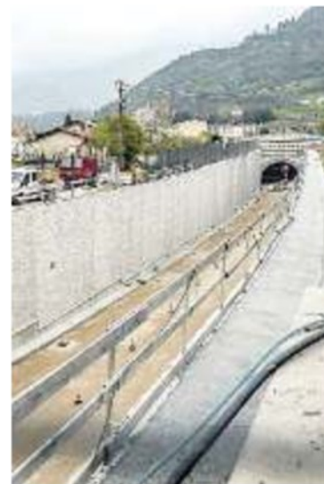
NUOVI SONDAGGI Si procede nelle opere per il traforo
