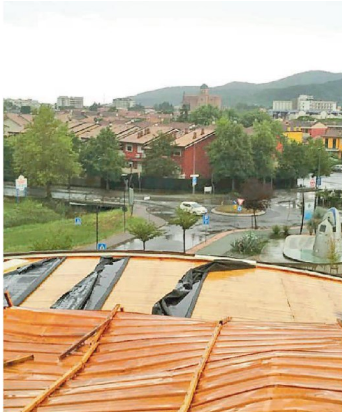
Una parte dei danni alla copertura del Palaberta
