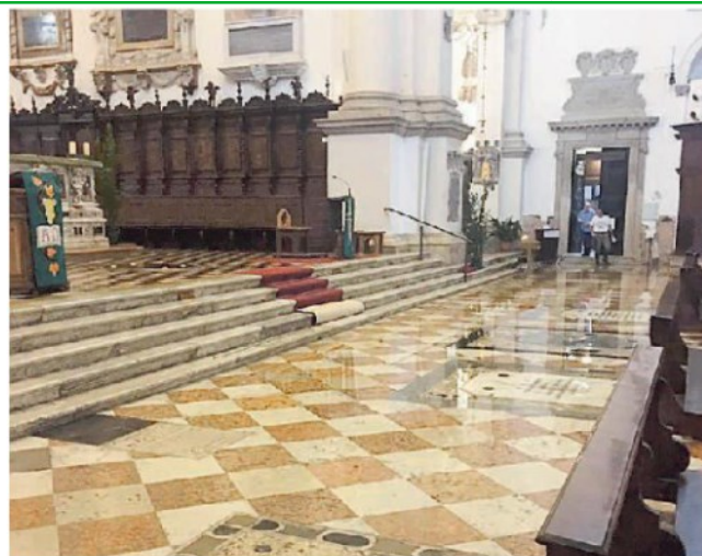
Il pavimento del Duomo di Chioggia allagato dopo il temporale
