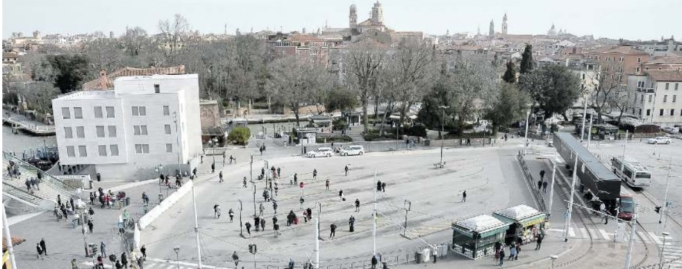
PIAZZALE ROMA Ad ottobre scatta il rifacimento dell'asfaltatura, che avverrà a fasce per consentire l'attraversamento ai mezzi che tutti i giorni lo impegnano
