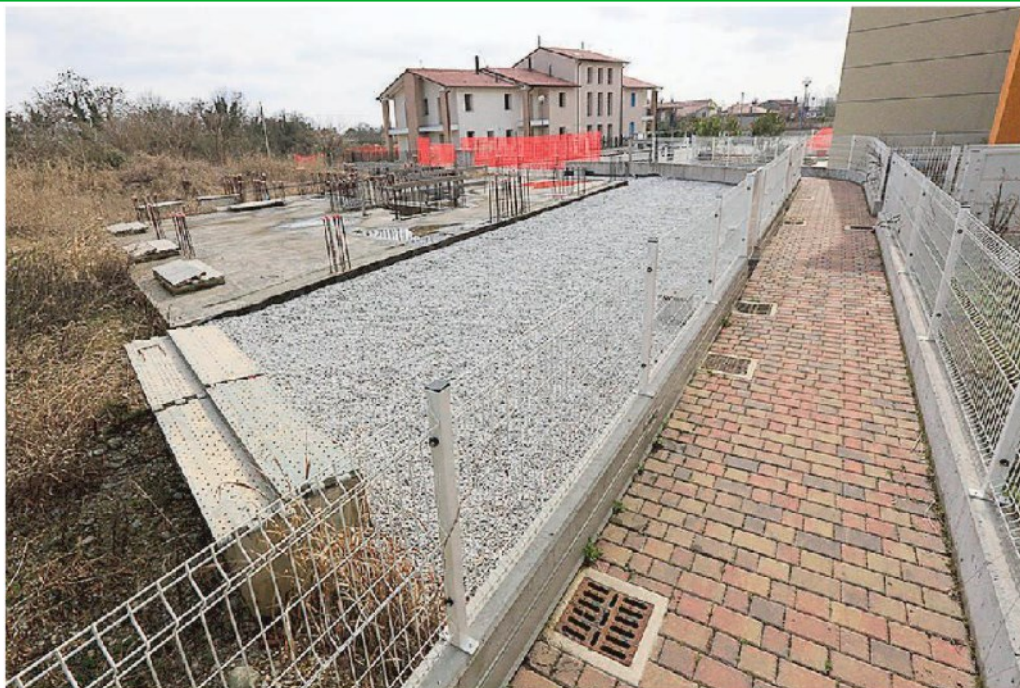
Edilizia, un cantiere a Montebelluna: qui siamo a Guarda in via Feratine
