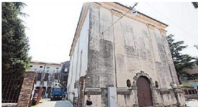
Il cantiere Cev nel chiostro di via Canova, a fianco di S.Maria Nova
