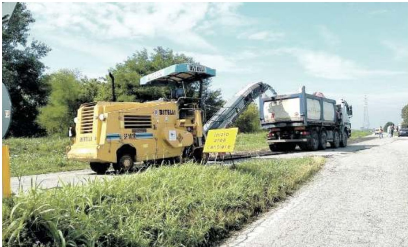
PROVINCIALE 41 I lavori di asfaltatura partiti sulla strada arginale in sinistra al Po di Venezia, per permetterne la riapertura
