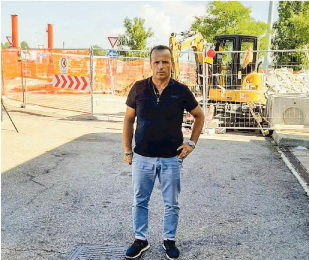
Islami Cefli, titolare di Edil Star, sul cantiere del velodromo di Spresiano
