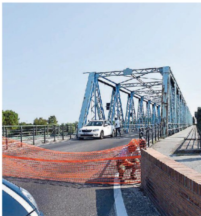
Lo smantellamento del cantiere sul ponte della Vittoria
