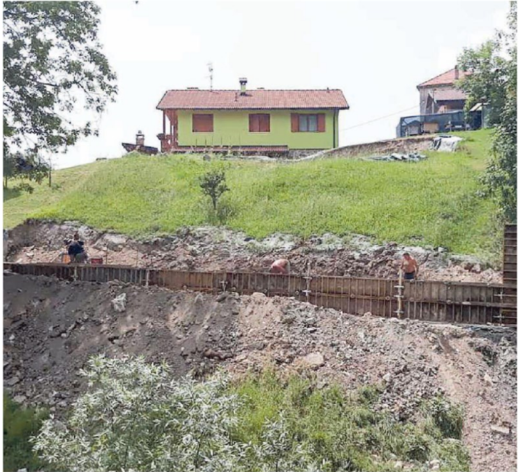
Uno degli interventi portati avanti dal servizio Difesa del suolo della Provincia
