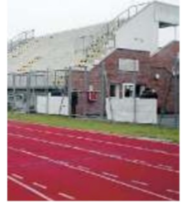
STADIO WALTER MARTIRE Stanziati fondi per rifare la copertura
