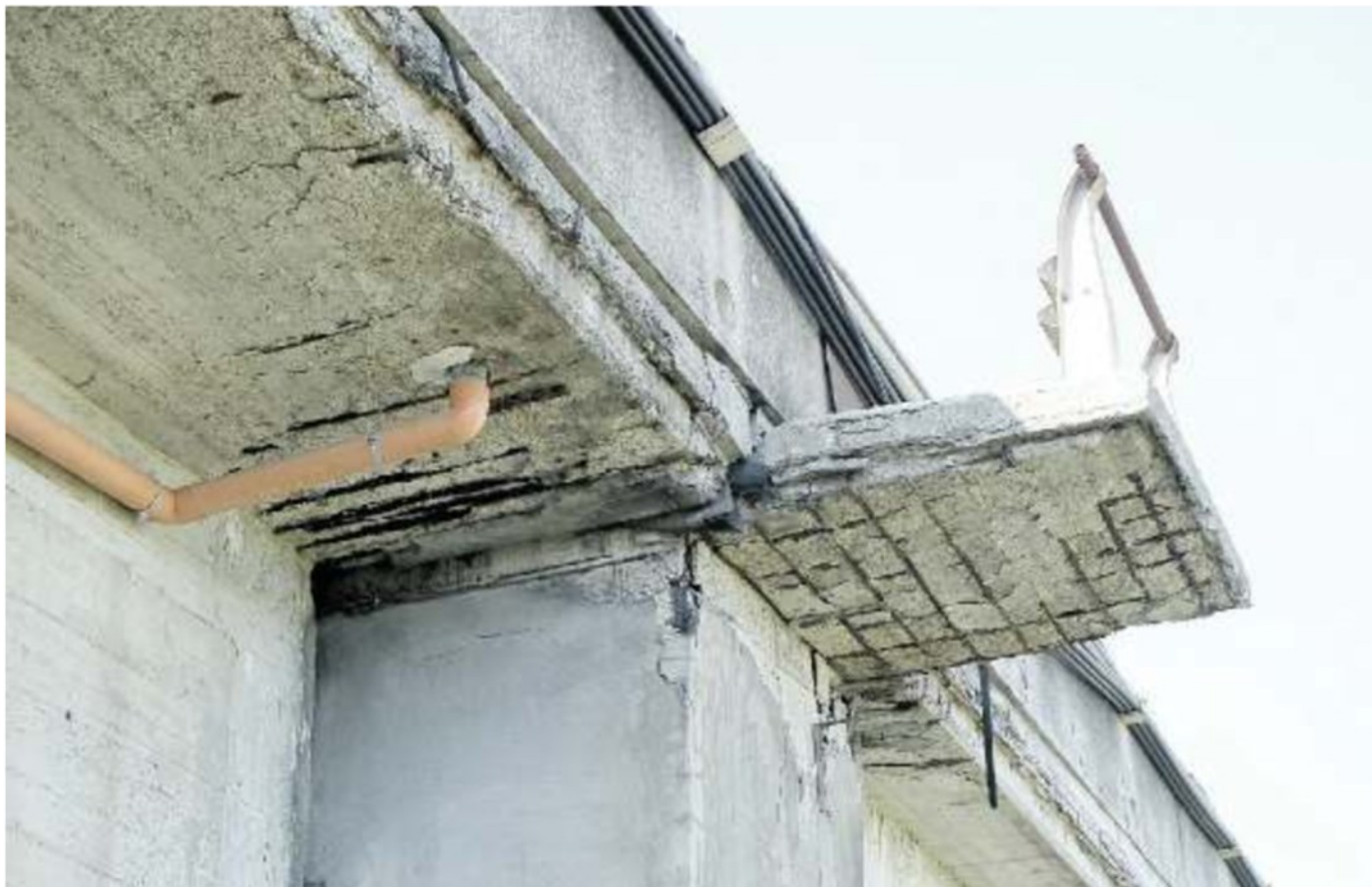
AUTOSTRADA Il pilone "logorato" del viadotto dell'A13; oltre a quello esterno, anche i manufatti centrali presentano problemi
