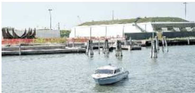
SOTTO CONTROLLO II deposito Gpl a Chioggia: lavori finiti in marzo
