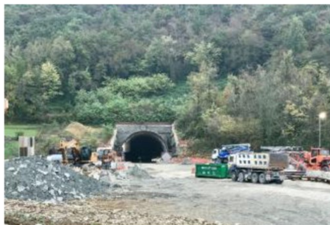
I lavori alla galleria di soccorso di Vallugana
