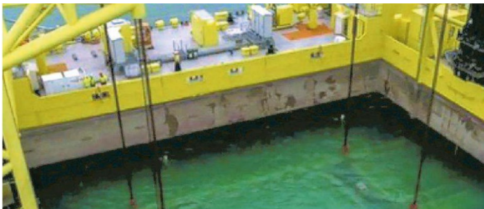
La posa in acqua dell'ultima paratoia del Mose al Lido: ora sono completate
