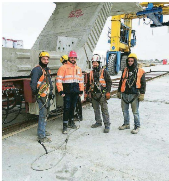
Operai impegnati nei cantieri della terza corsia in A4
