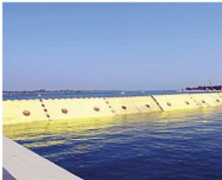
Paratoie A sinistra, un test con le dighe mobili. A destra, la nave che ha trasportato l'ultima paratoia
