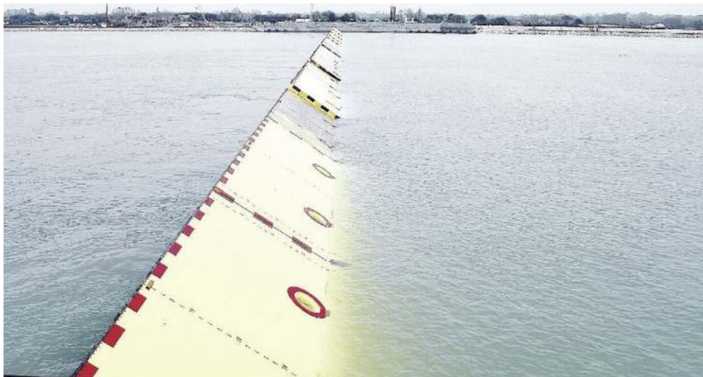
BARRIERA La barriera di Treporti nell'ultima prova di sollevamento del 2014; sopra il jack-up al lavoro ieri per la posa dell'ultima paratoia di San Nicolò
