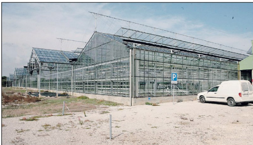
Gli stabilimenti della Florsystem di Polesine Camerini
