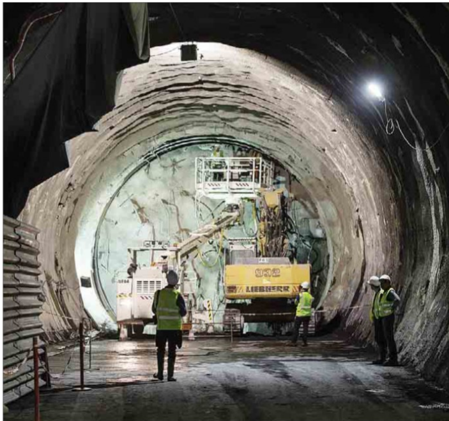
L'avanzamento dei lavori per la Tav, la contestatissima Torino-Lione
