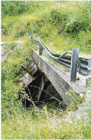
IL PONTE SUL QUALE INCOMBE LA FRANA DELLA BORGATA PONTALPINA DI PARADISI
