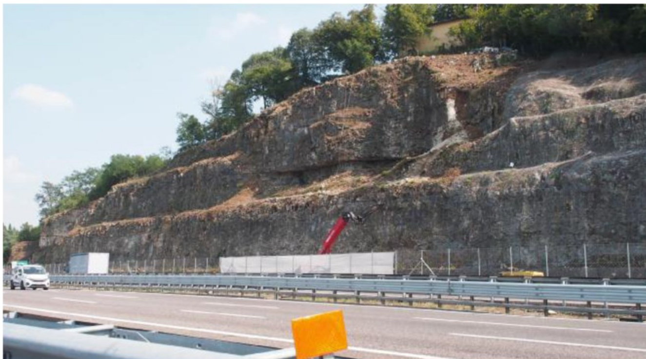
Da qualche settimana ruspe in azione lungo l'autostrada A4, poco dopo le gallerie beriche, per i lavori di messa in sicurezza. COLORFOTO
