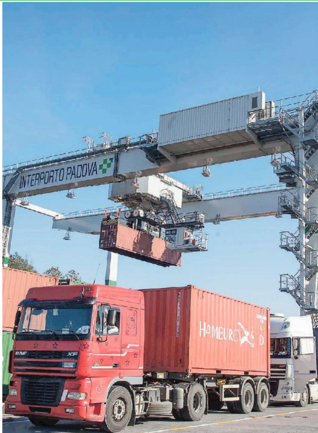
Operazioni di carico container con le nuove gru a portale installate all'Interporto di Padova
