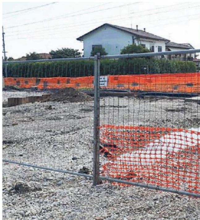
Il cantiere per il sottopasso alle Crete di Quarto d'Altino
