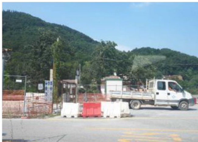
L'ingresso del cantiere della Pedemontana a Vallugana. MA.CA.
