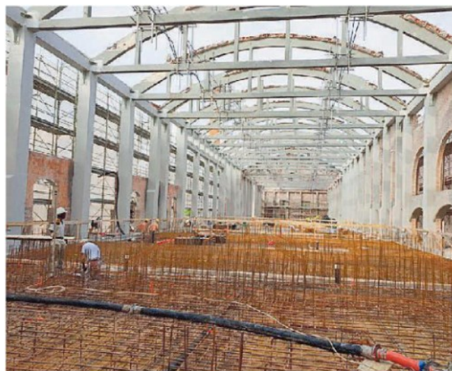
Lavori in corso per i 16 alloggi nelle ex Conterie
