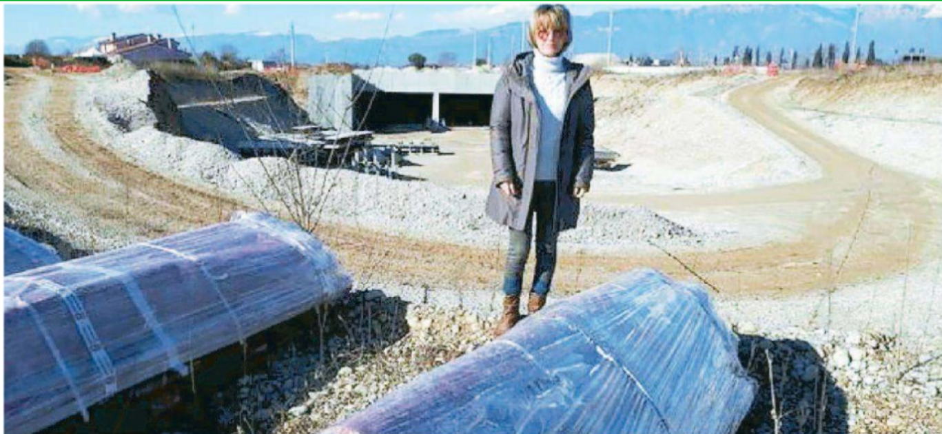
La perita del Tribunale Marina Lecis davanti ai tubi coperti di nylon all'interno del cantiere
