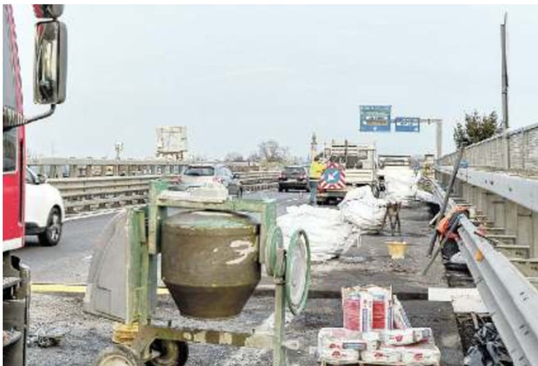
A PASSO D'UOMO Il cantiere sul ponte che ha causato code e disagi lungo la Tangenziale per Paese
