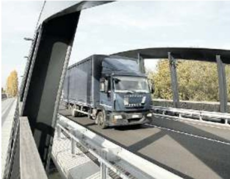
INCOMPIUTO Oggi il tracciato del Terraglio Est si ferma a Casier
