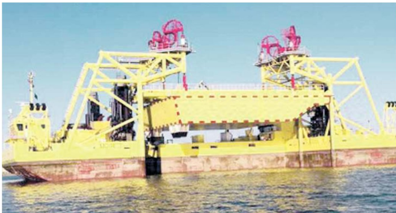
PARATOIA La posa dell'ultima paratoia del Mose a 12 metri di profondità alla Bocca di Porto del Lido. A marzo cominceranno i primi test di sollevamento
