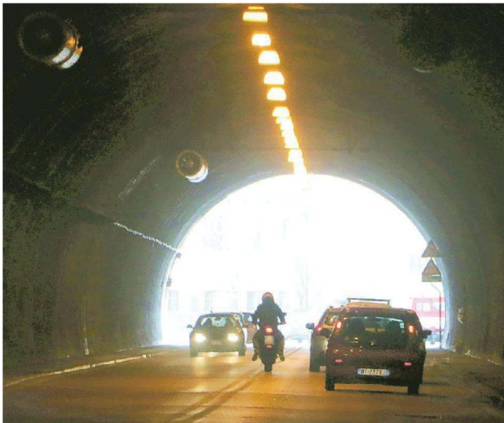
La galleria di Montebello attende dal 2002 il cantiere per la riqualificazione. Foto Lasorte
