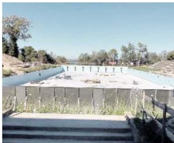
EX ASILO Dopo il via libera del Comune i lavori per la nuova piscina dovrebbero terminare la prossima primavera
