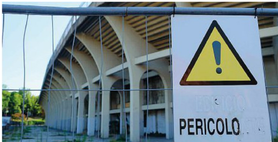
Fatiscente La gradinata est dello storico Appiani. Il Comune pensa al referendum per decretarne o meno l'abbattimento (Bergamaschi)
