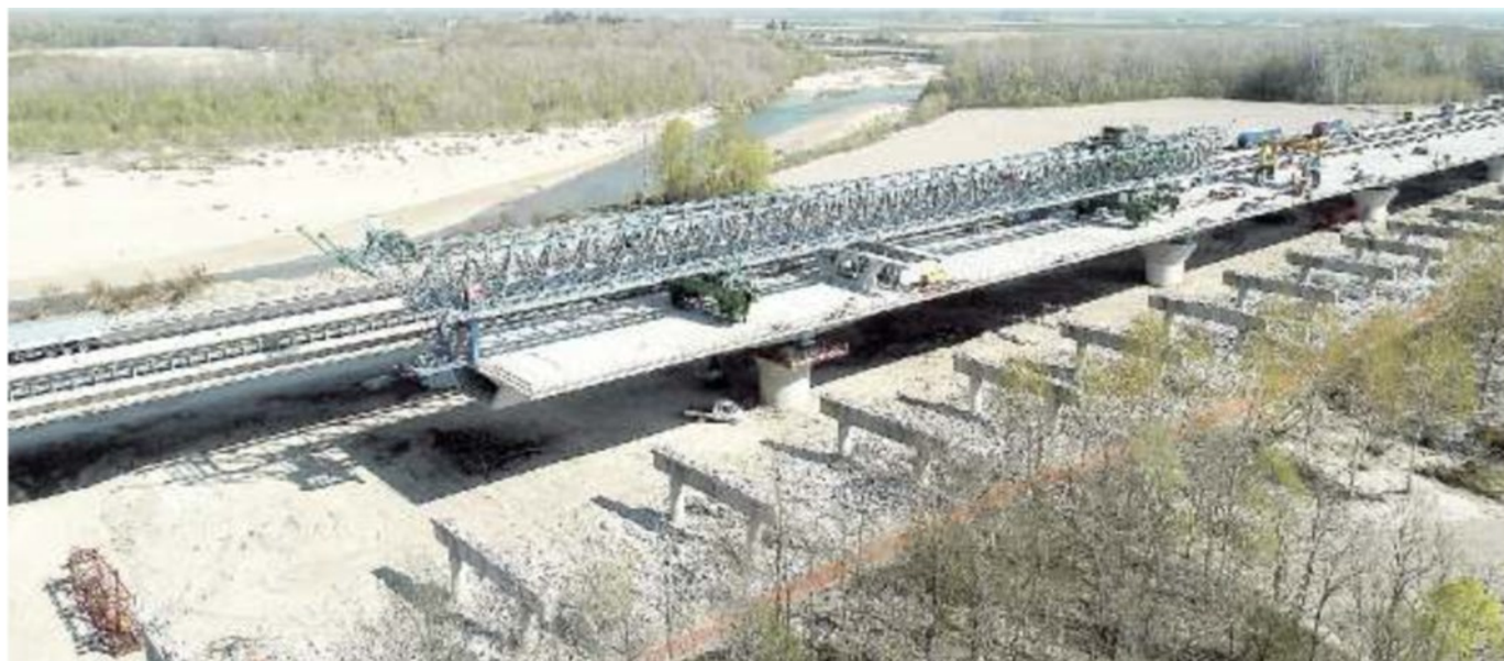
GRANDI OPERE Una vista dall'alto del grande "carro varo", che ha sovrastato il fiume per 2 anni.
