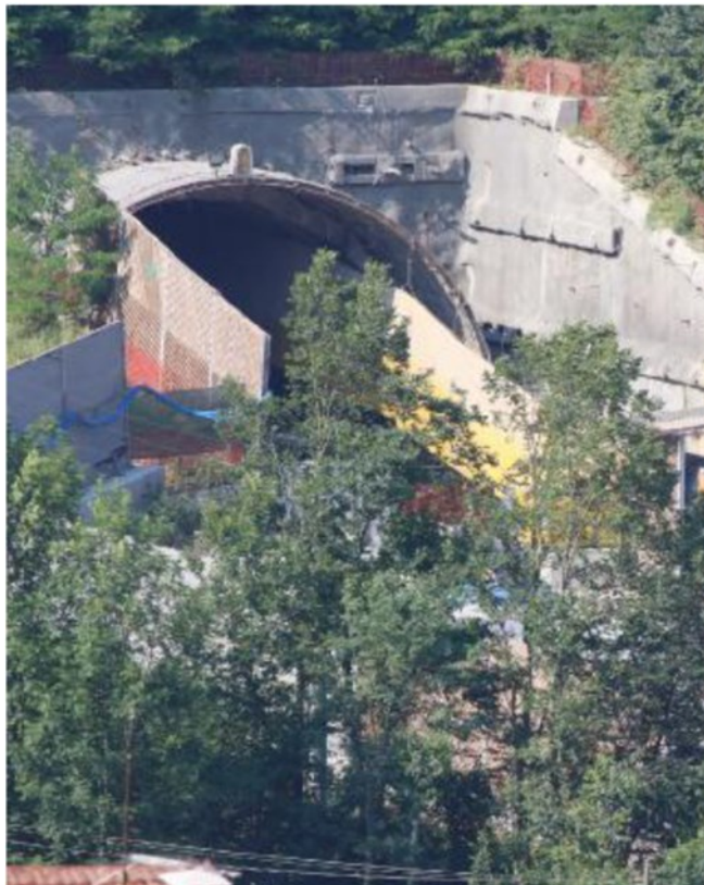
Il tunnel della Pedemontana che era finito sotto sequestro
