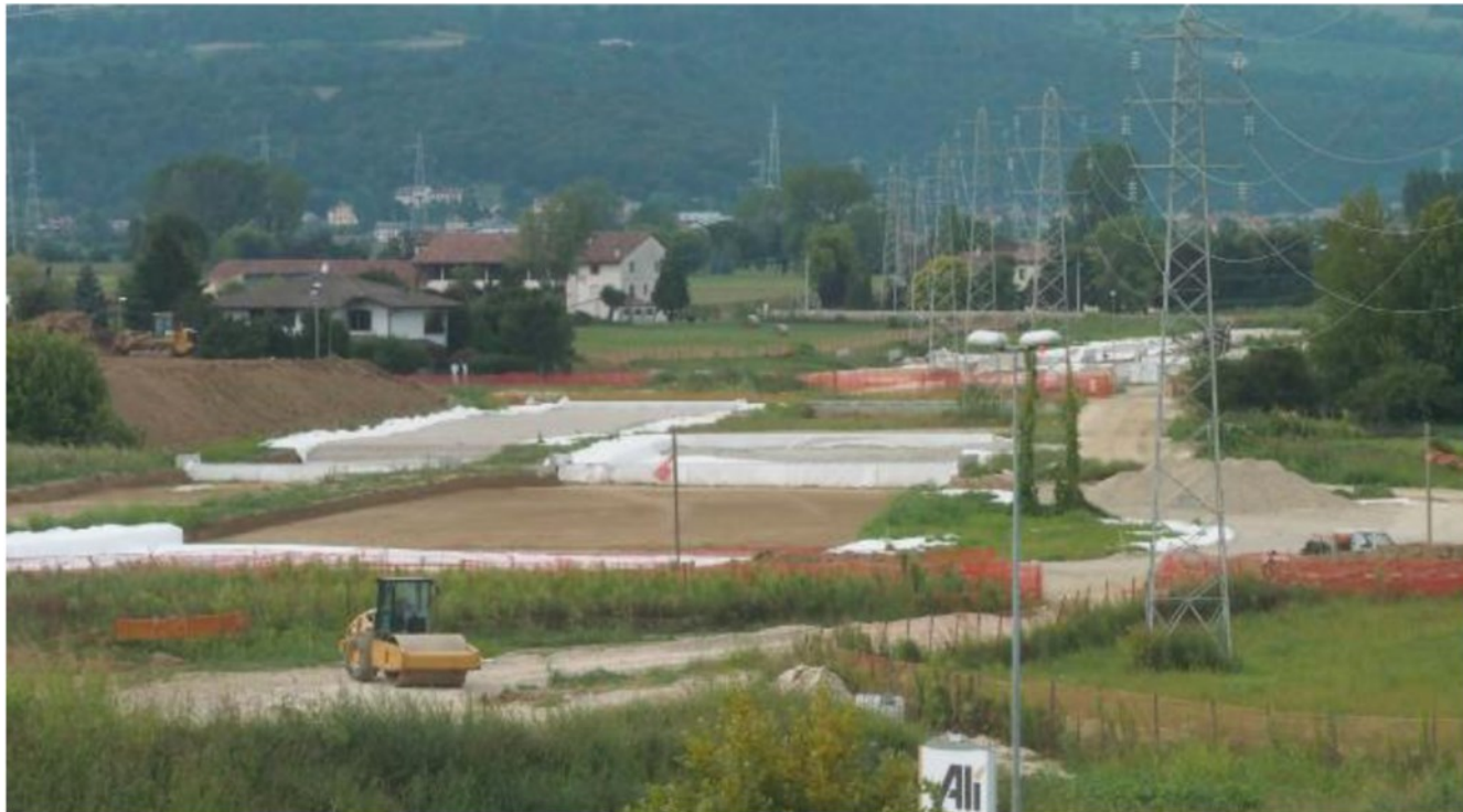
Veduta del cantiere della tangenziale Ovest che, secondo la lettera di Anas al comitato dell'Albera, terminerà a dicembre 2020. COLORFOTO
