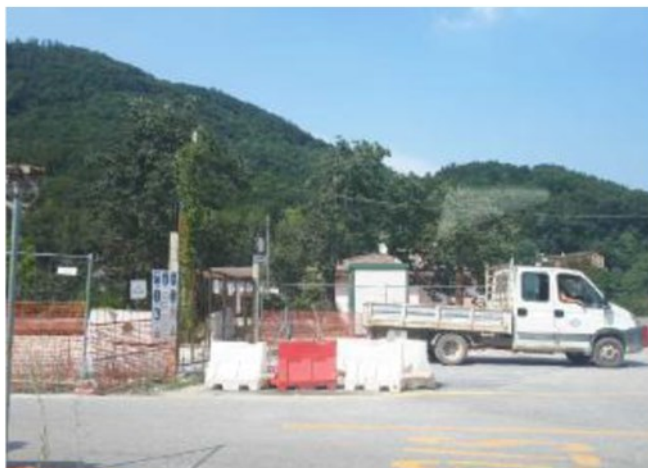
Il cantiere della Pedemontana aperto a Malo
