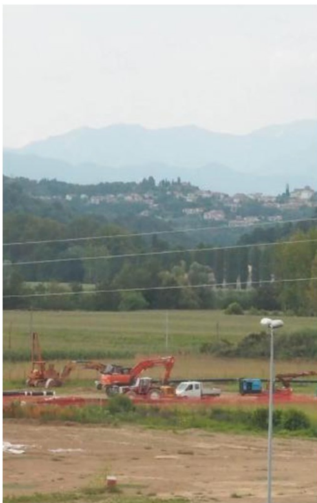
Ruspe al lavoro nell'area dove sta nascendo la tangenziale. COLORFOTO
