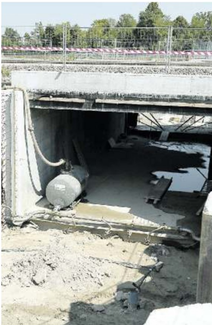
SECONDO ATTO I lavori preliminari per la realizzazione del sottopasso in via Ronchi. In alto, l'inaugurazione di via Villastorta
