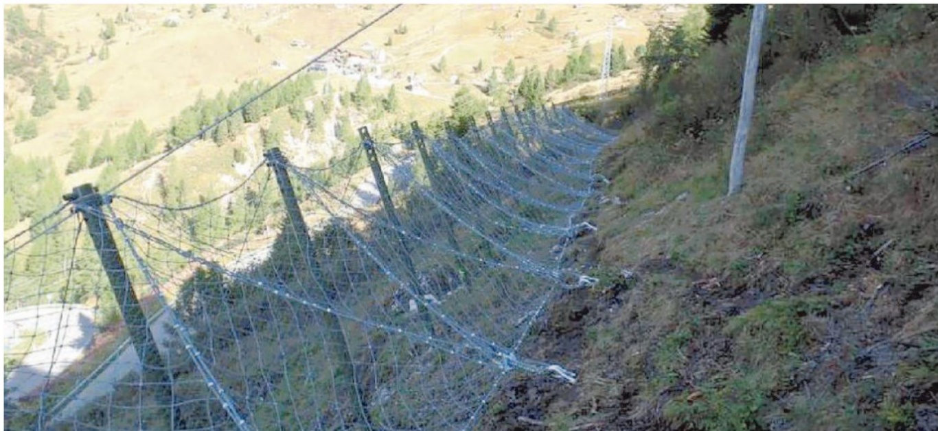
Paramassi realizzato dopo Vaia
