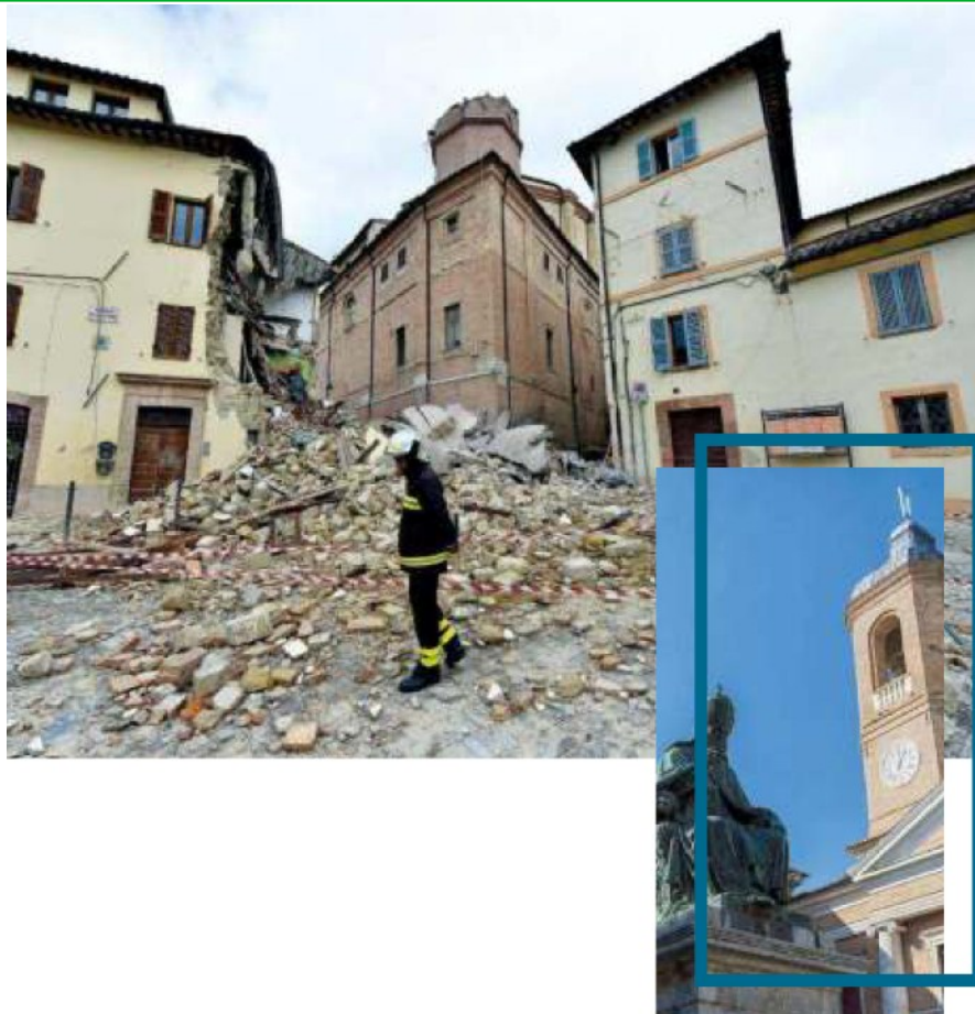
A sinistra: il campanile della chiesa di Santa Maria in Via a Camerino nell'ottobre 2016. La cittadina, colpita da una sequenza sismica, è stata enormemente danneggiata. Sopra: Piazza Cavour, con la statua di Papa Sisto V
