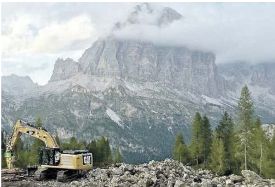
L'OPERA in corso nella ski area delle 5 Torri per la pista Lacedelli: da ieri i lavori sono ripresi
