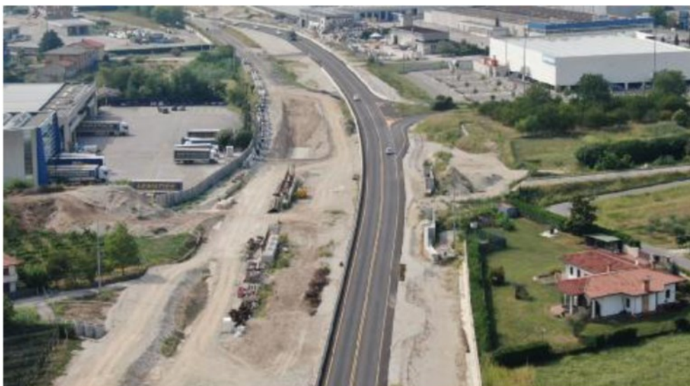
Tra via Baggi e viale De Gasperi procedono i lavori per la costruzione del viadotto. CECCON
