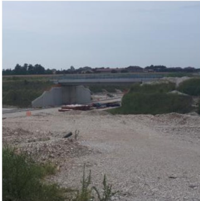
L'area di cantiere a nord del casello Spv Casoni-Loria a Mussolente
