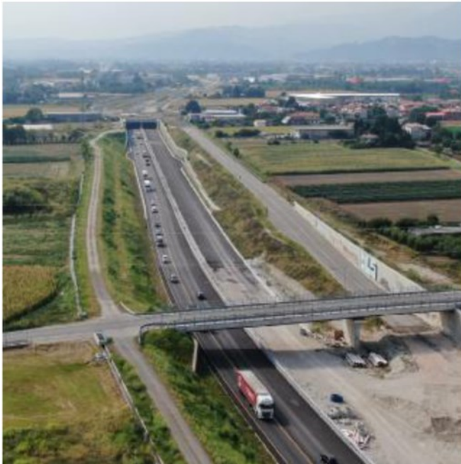
Il viadotto di via Carpellina e sullo sfondo il rondò di via Ca' Dolfin
