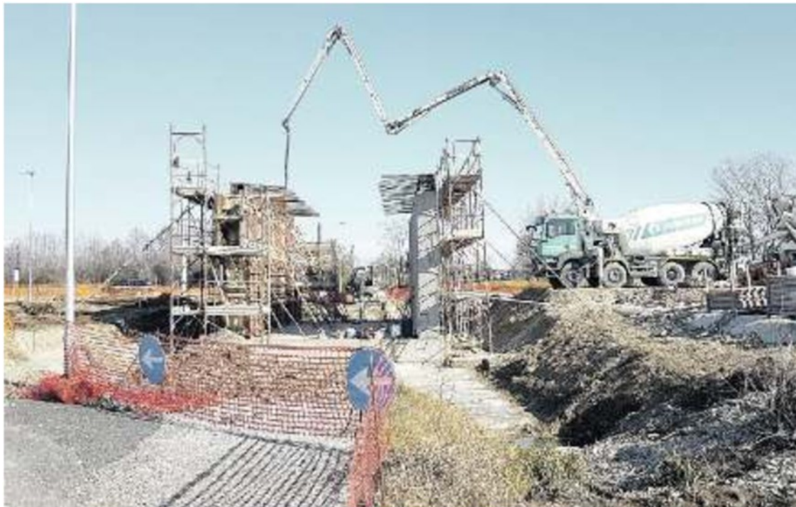
CANTIERE La costruzione del sottopasso in via Porchiarina, che porta alle Olle di risorgiva
