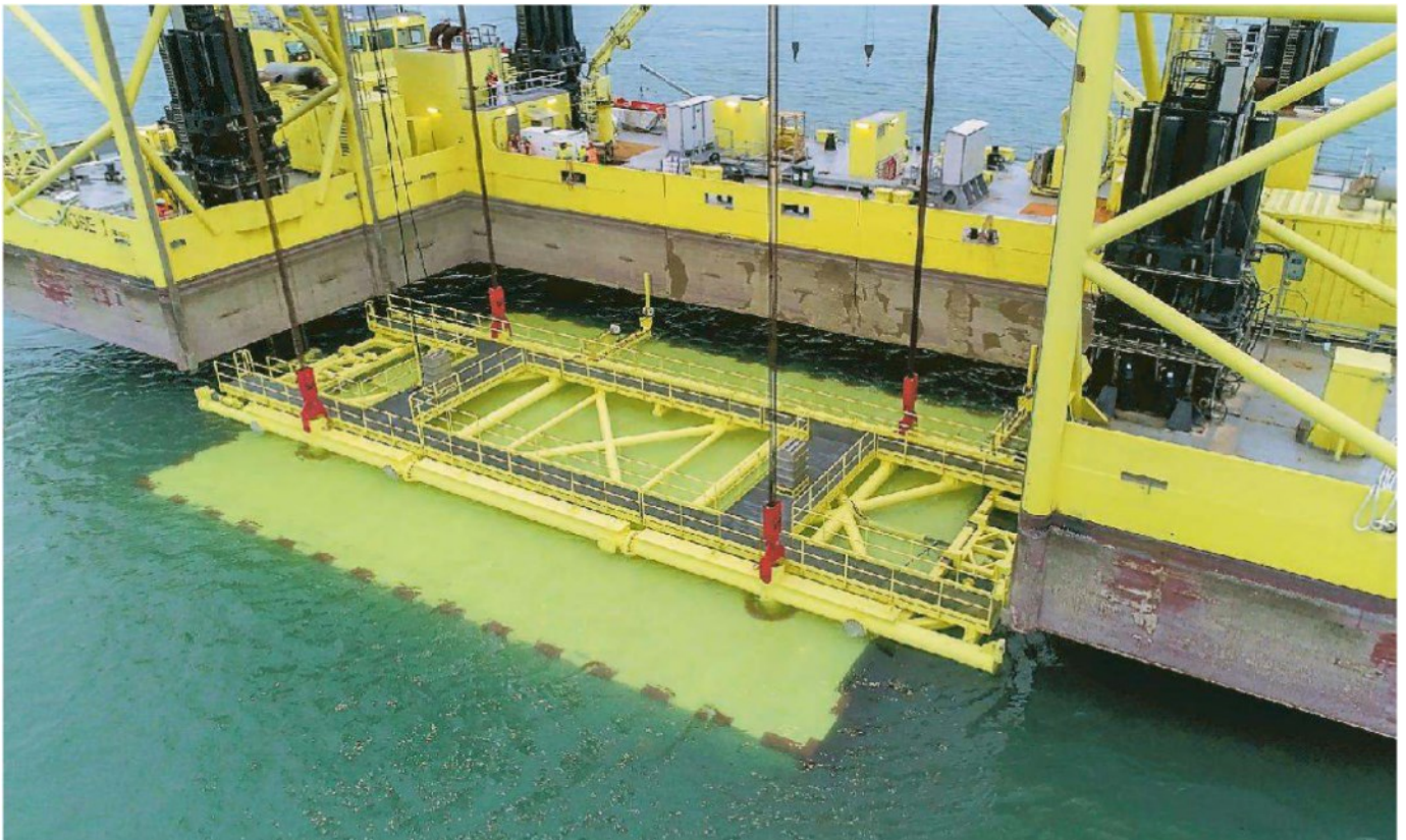
Le operazioni di posa dell'ultima paratoia del Mose al Lido: in tutto ne sono state posate settantotto
