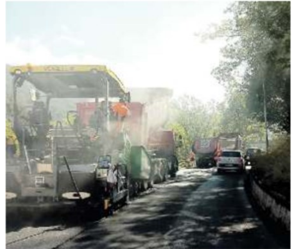
ANAS I lavori di asfaltatura tra Criol e Cadola dove in questi giorni si sono registrati forti rallentamenti del traffico
