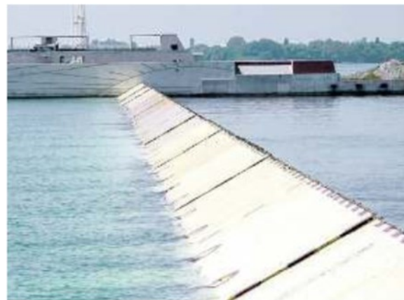
I TEST La sperimentazione del sollevamento delle paratoie del Mose alla bocca di porto di Chioggia
