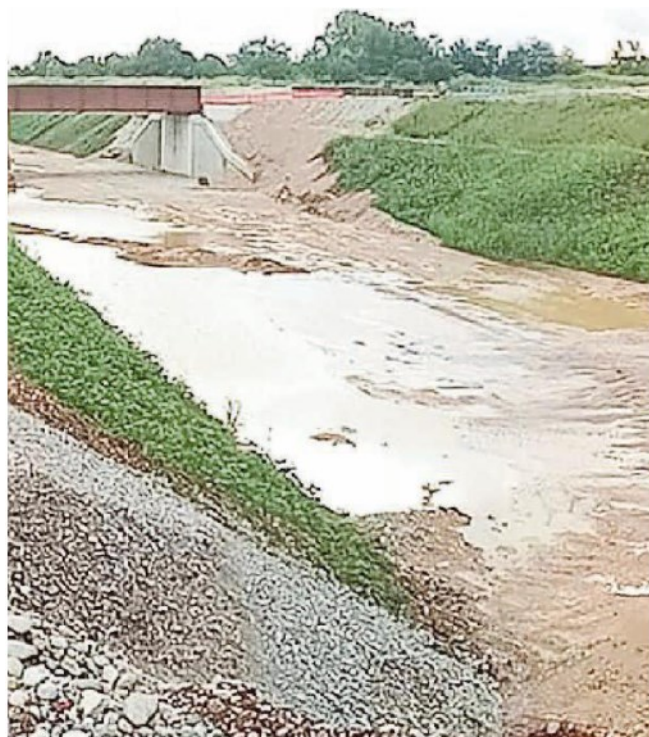
Il cantiere della superstrada allagato
