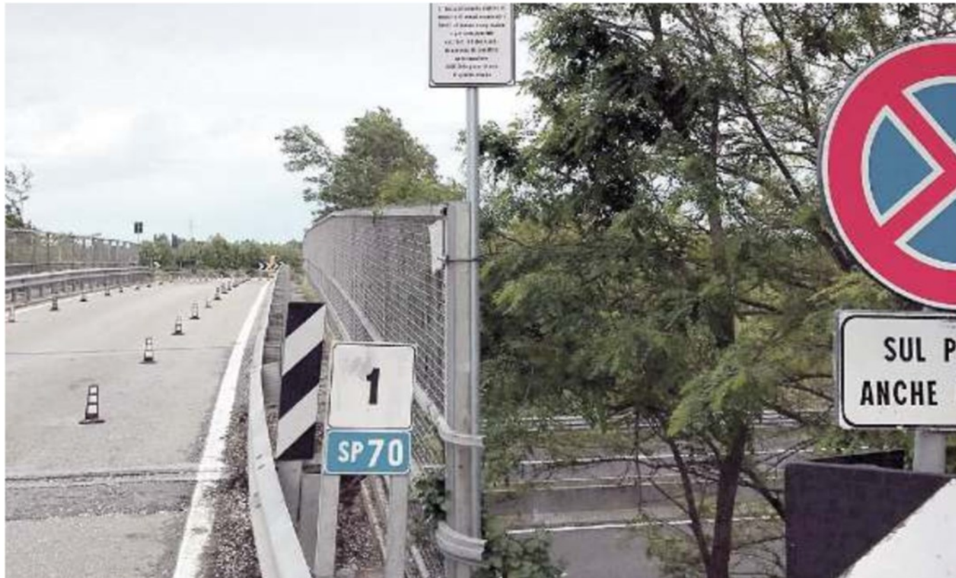
CAVALCAVIA Il ponte sull'A13 verrà chiuso totalmente al traffico, dalle 22 di sabato fino alle 24 di lunedì 30 settembre
