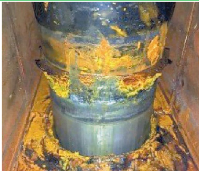
La corrosione in una cerniera del Mose sotto la laguna
