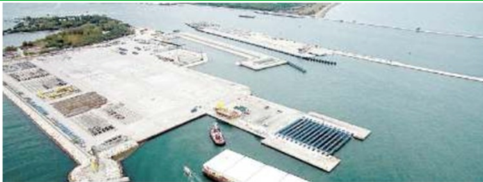
FASE FINALE Una veduta dei lavori di costruzione del Mose
