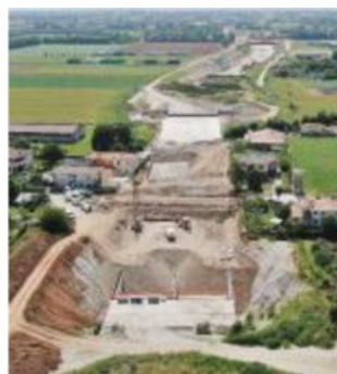
L'area dei lavori a Casoni
