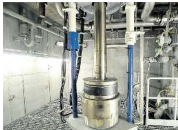
MOSE Le cerniere che tengono ancorate le paratoie
