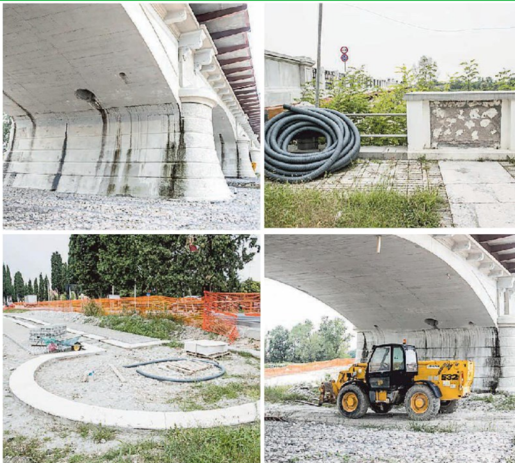
IL LATO B di Ponte della Priula dopo il restauro: piloni già rovinati, mezzi abbandonati, cantieri sospesi
