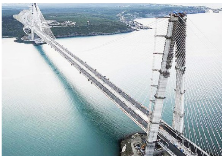
Astaldi. Il terzo ponte sul Bosforo a Istanbul
