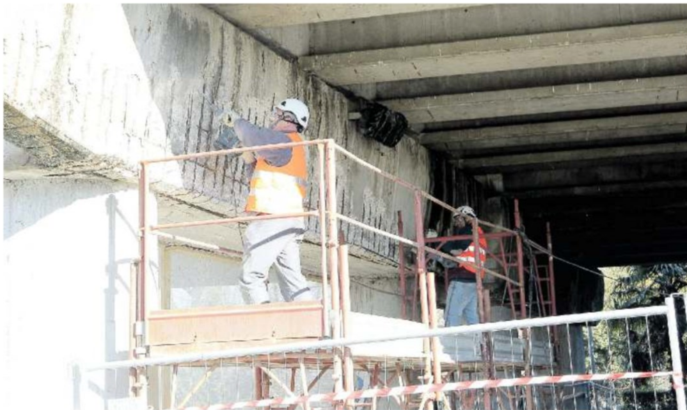
IL CANTIERE Sono cominciati ieri i lavori sotto il cavalcavia di Sant'Angelo: dureranno un mese per una ventina di giorni sulla tangenziale si viaggerà a una corsia
