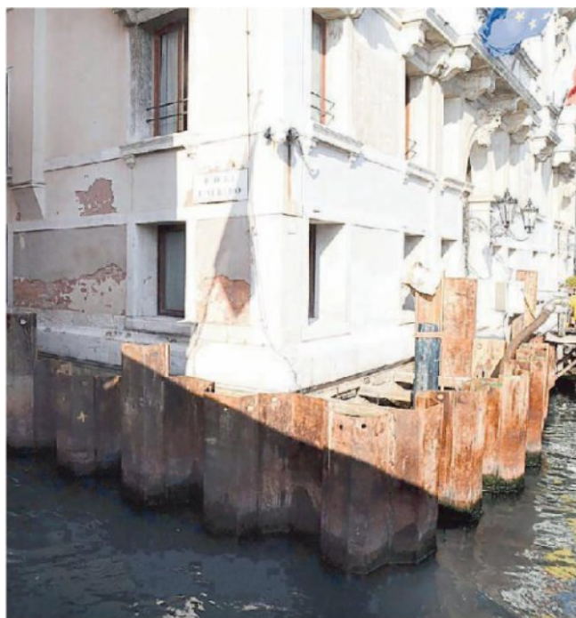
L'angolo di Palazzo Ferro Fini interessato dai lavori
