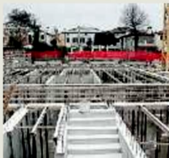
Aldighieri a pagina X EDILIZIA Un cantiere
