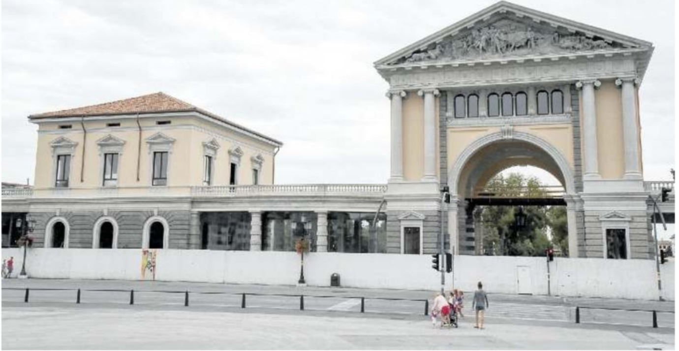
EX FORO BOARIO La Cavagnis costruzioni Srl ha partecipato alla riqualificazione di Prato della Valle anche con la realizzazione del parcheggio in piazza Rabin
