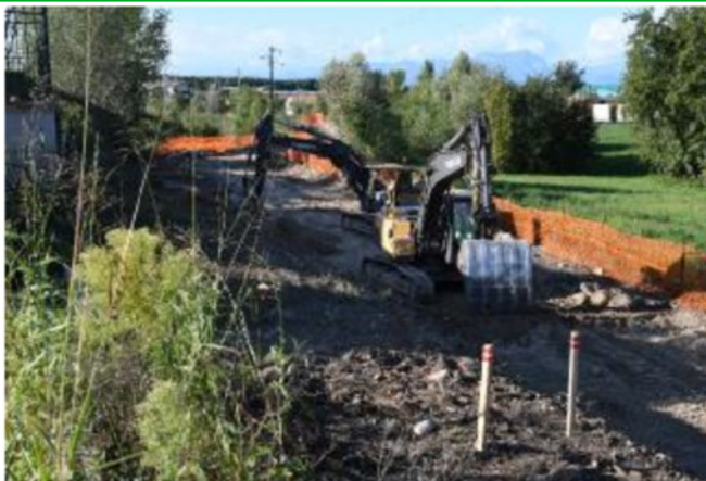
Un cantiere per la Tav aperto a Peschiera del Garda
