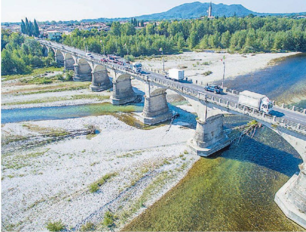
Il ponte di Vidor visto dall'alto, è stato costruito nel 1911, ultimo restauro nel 1984. Poi solo manutenzione
