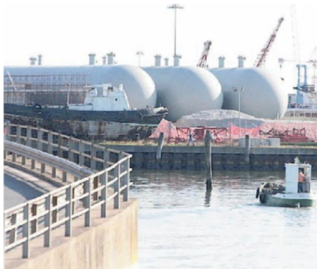
Il deposito di Gpl in corso di costruzione
