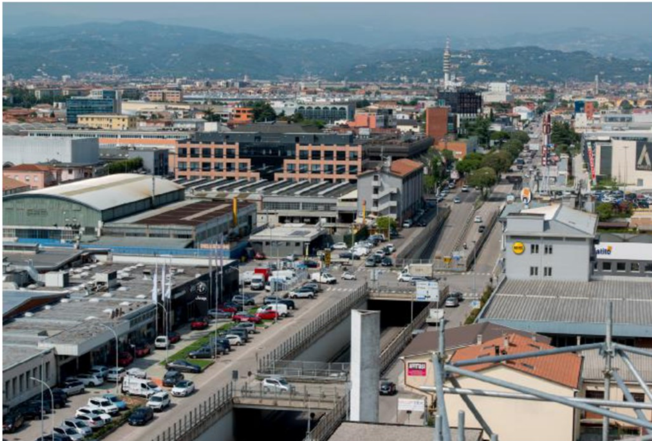
La Zai, a sud della città, interessata come altre zone da progetti di nuova edificazione e di riconversione edilizia, residenziale e commerciale
