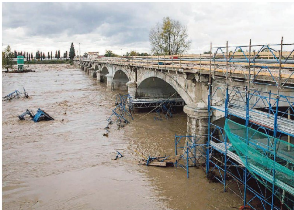
Il Ponte della Priula con le impalcature del cantiere spazzate via dalla furia delle acque
