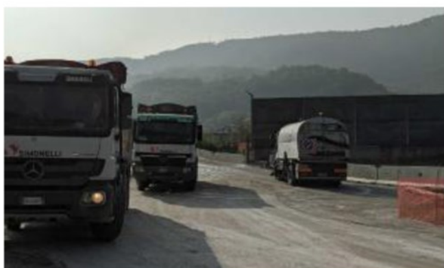
Il via vai di automezzi dal cantiere di Vallugana
