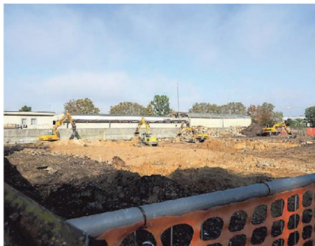
Il cantiere di costruzione della nuova piscina in via Delle Macchine
