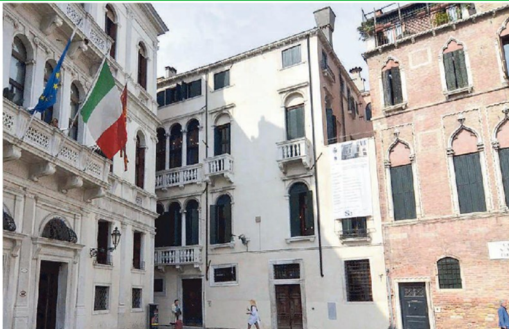
Palazzo Donà in Campo Santa Maria Formosa ristrutturato per trasformarlo in albergo
