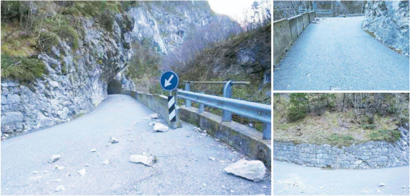
Nelle foto alcune immagini della situazione in cui versa la strada provinciale della Valle del Mis dopo l'alluvione della fine di ottobre 2018. Sono partiti, già, i lavori di sistemazione della Sp 2 da parte di Veneto
