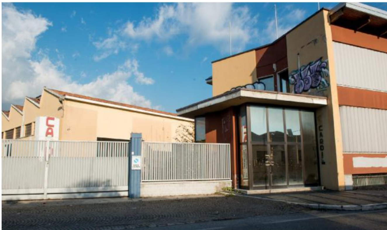
L'ingresso dell'ex stabilimento Cardi a Chievo FOTO MARCHIORI
