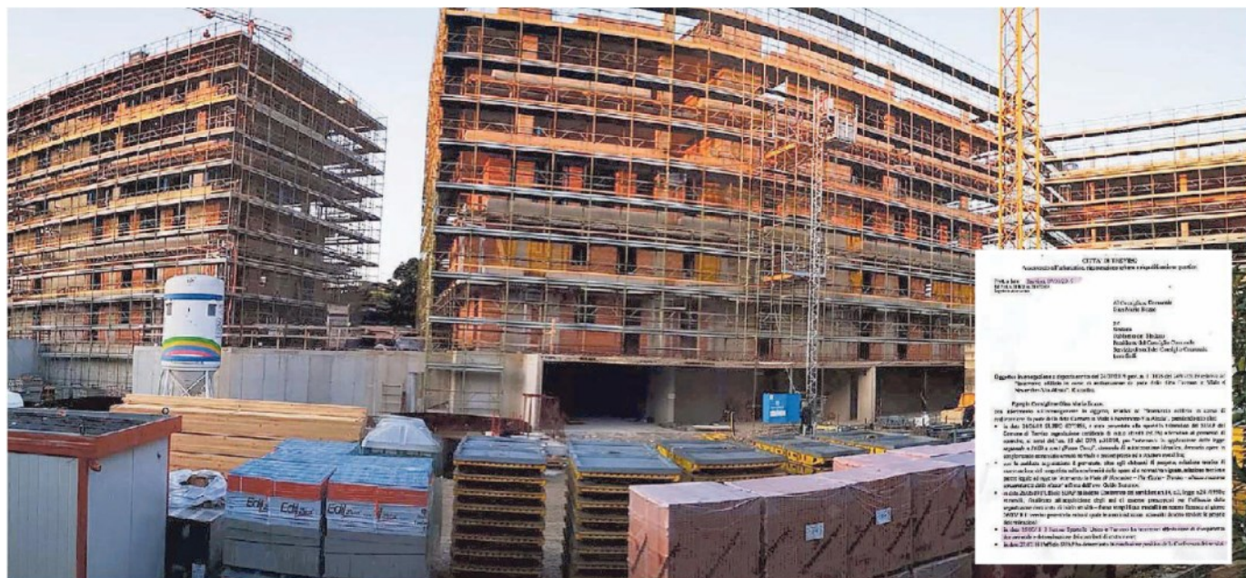
Il cantiere per la realizzazione del residence Ca' delle Alzaie, ovvero il Bosco verticale, lungo la Restera a Fiera. E la lettera dell'assessore Tassinari dell'agosto scorso
