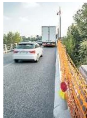
IL PARAPETTO del ponte di Vidor divelto da un camper
