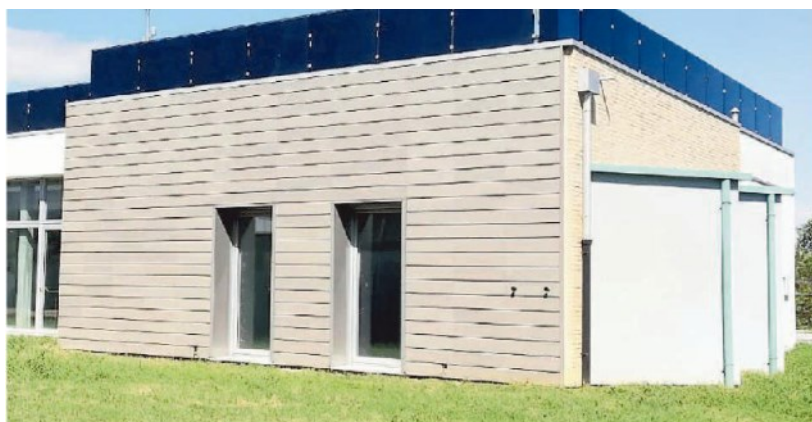
Una delle facciate della Casa dell'Energia realizzata con diversi materiali per testarne l'efficienza
