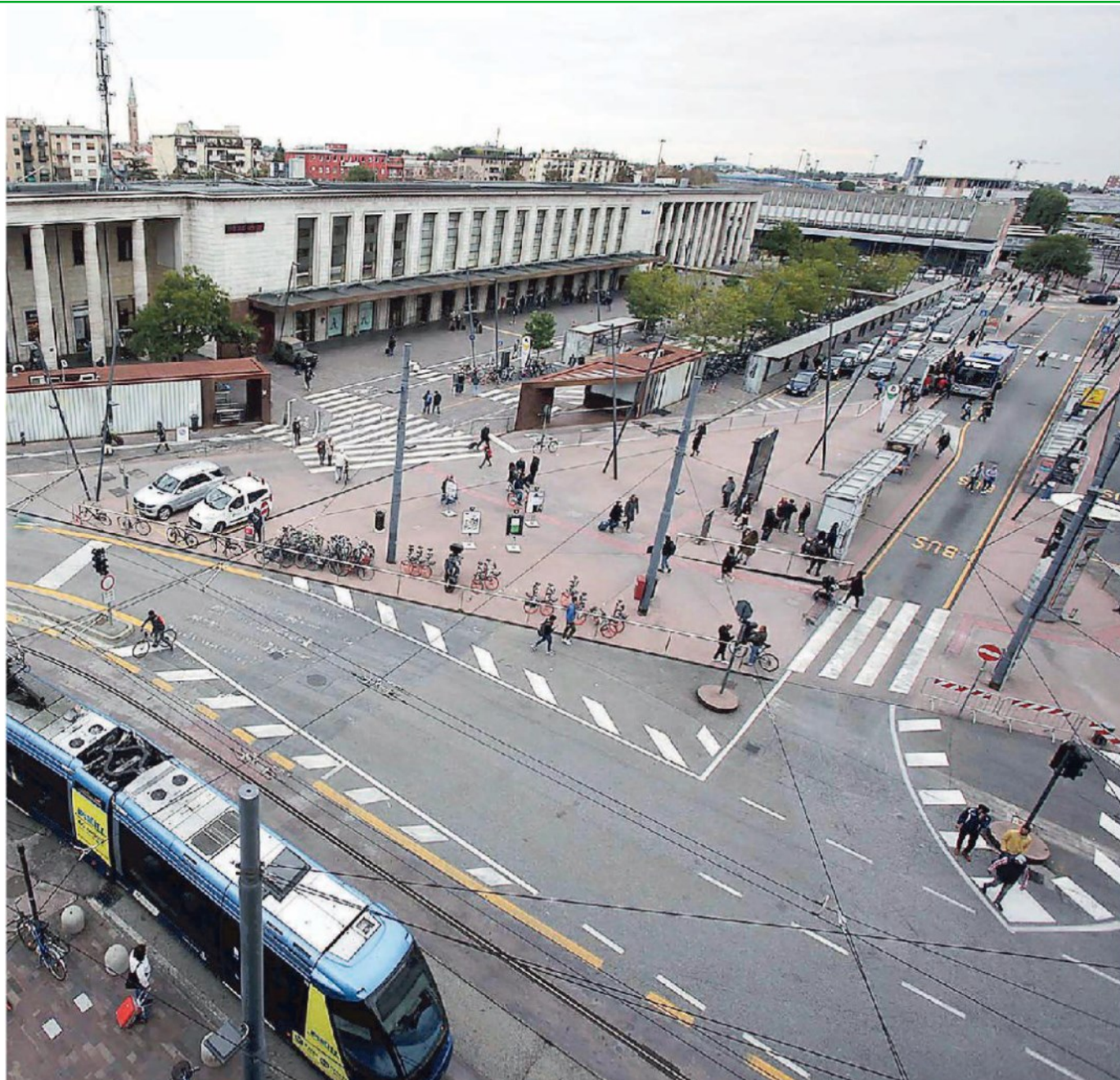
L'area di piazzale stazione vista dall'alto: il degrado della zona ha fatto crollare le quotazioni immobiliari
