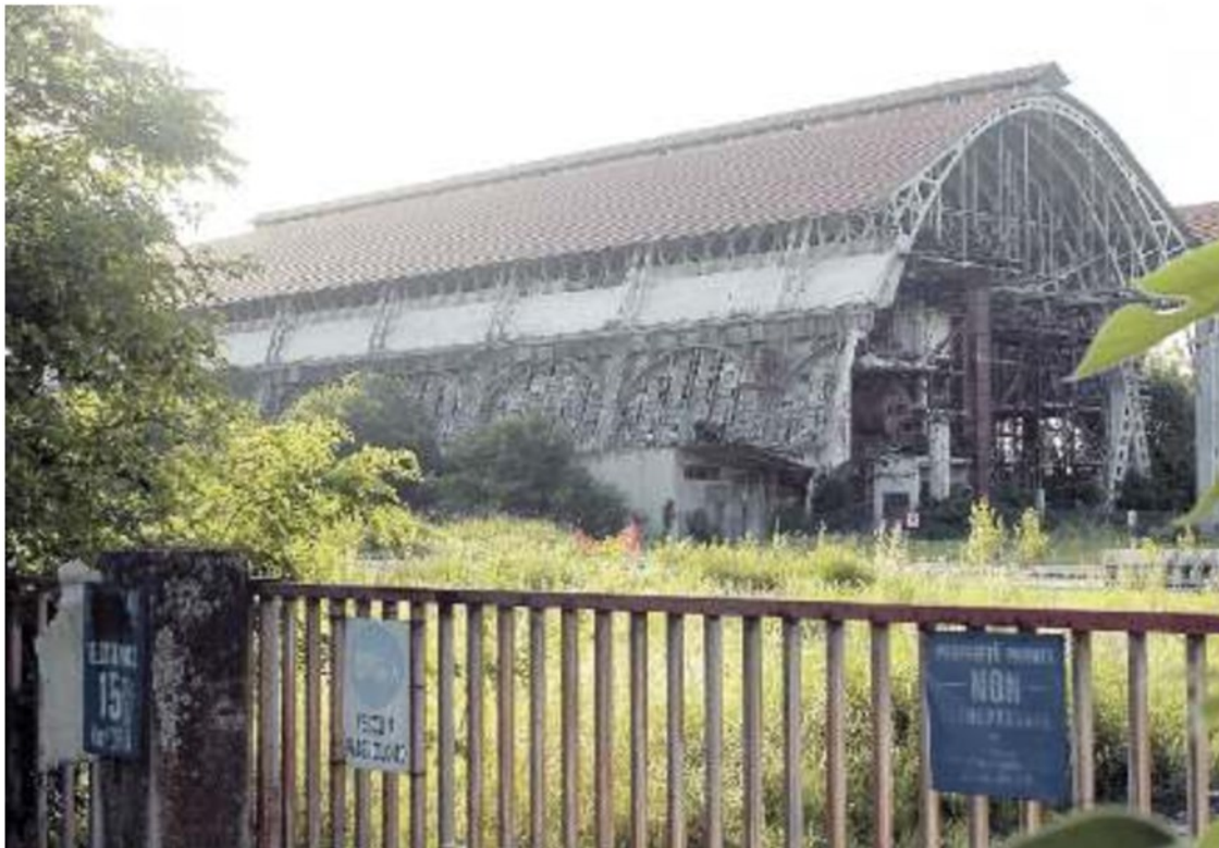
PROGETTI DI RECUPERO Un'immagine della ex Perfosfati a Portogruaro
