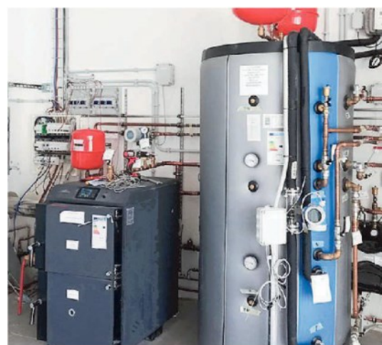
All'interno del laboratorio sono state installate strumentazioni hi-tech
