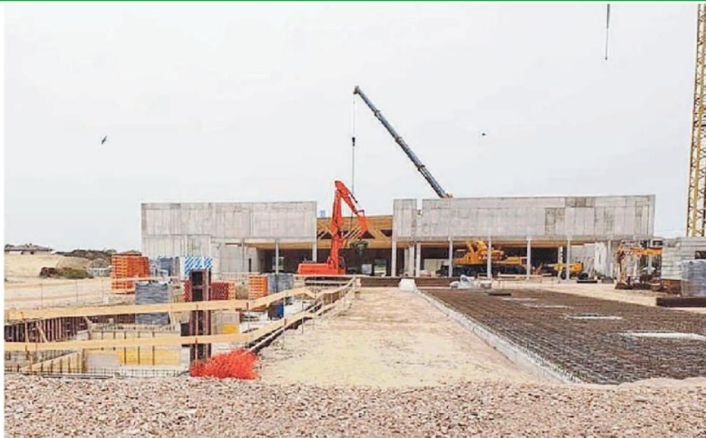
Il cantiere per la costruzione della piscina dedicata a Bud Spencer in viale della Repubblica a Tencarola
